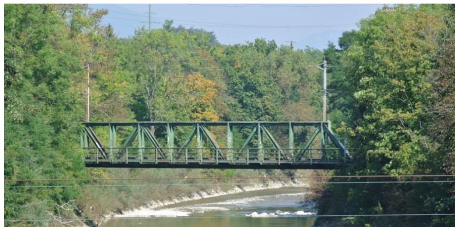
Abbildung 18 Wegen der nahtlosen Bewaldung der Ufer ist der Flusslauf meist nur von Brücken einsehbar (Bild: BLS-Eisenbahnbrücke mit Fussgängersteg)
