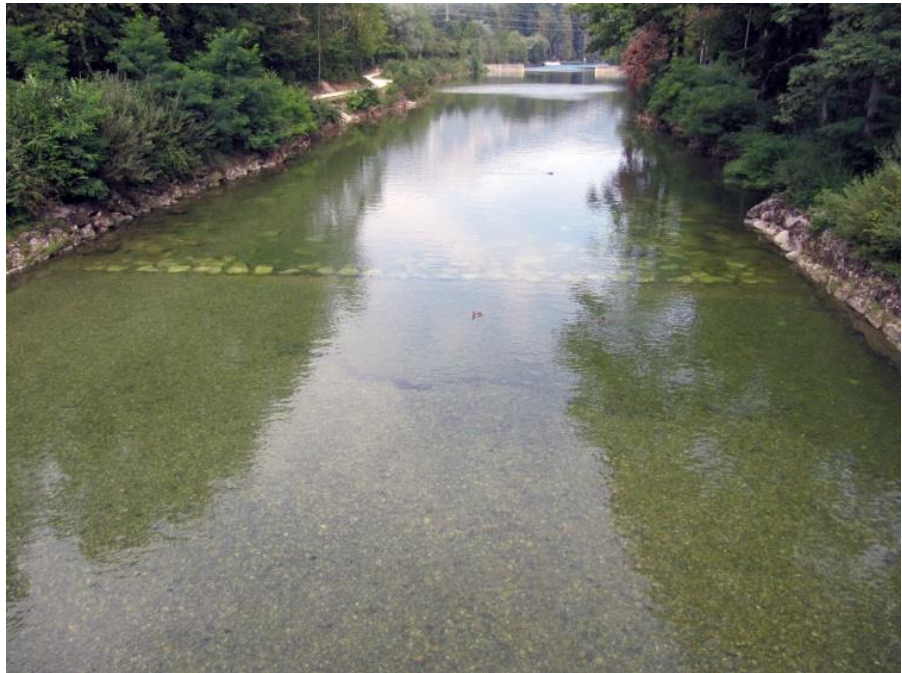
Abbildung 10 Spundwandschwelle (km 0.547) bei vollem Kiessammler und Rückstau aus der Aare
