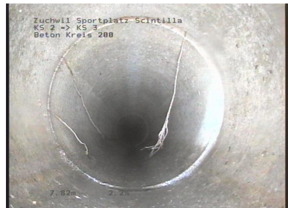
Wurzeleinwuchs bei Rohrverbindung
