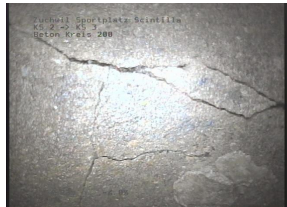
Rissbildung in Rohrwand
