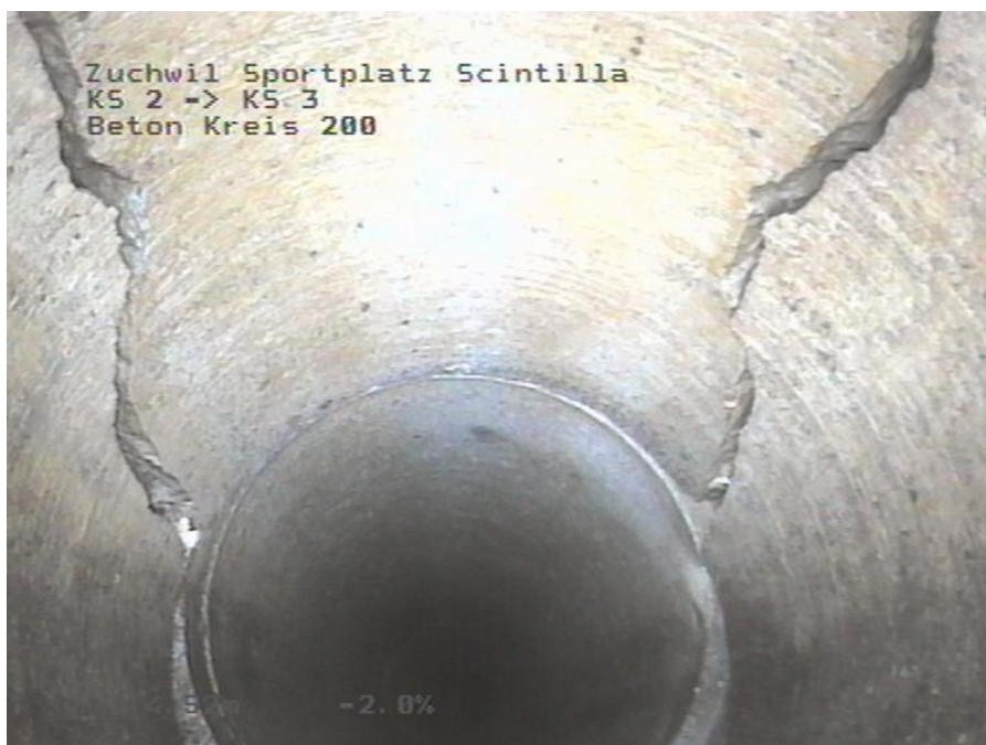
Kanalisation Entwässerung Sportplatz – DN 200 mm – Rohrbruch
