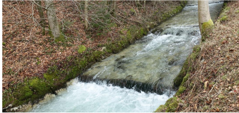
Abbildung 25: Holzschwelle im Abschnitt 1
