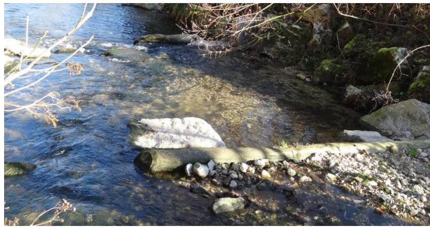
Abbildung 26: Umgebaute Holzschwelle
