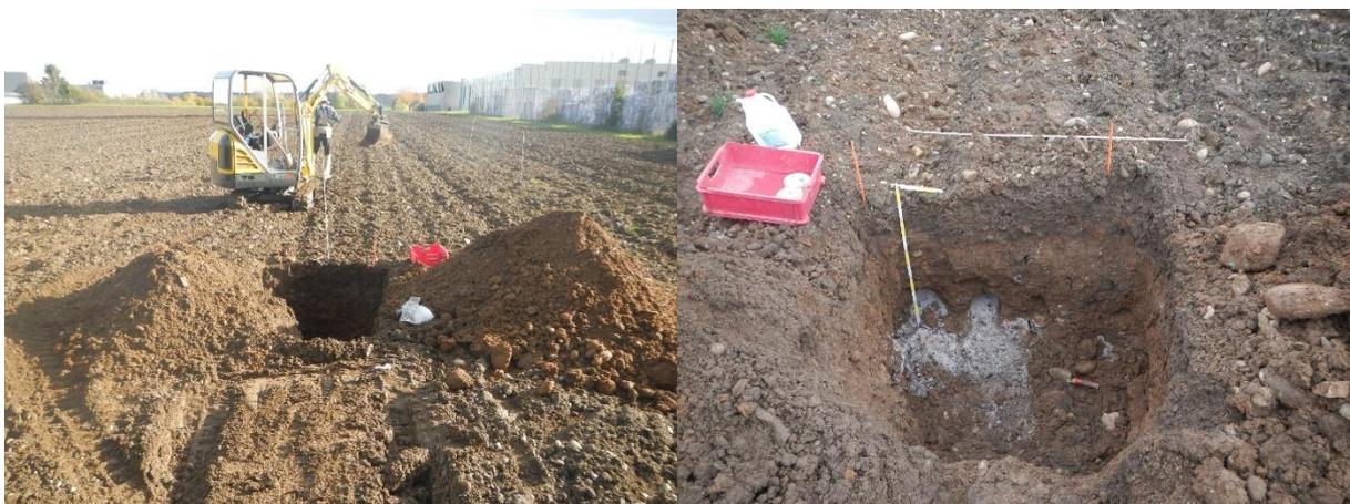
Abbildung 7: Einbau der SIA in 80 cm Tiefe.
