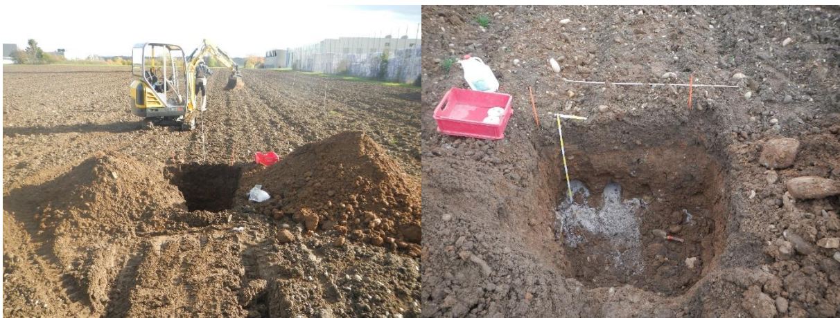
Abbildung 7: Einbau der SIA in 80 cm Tiefe.
