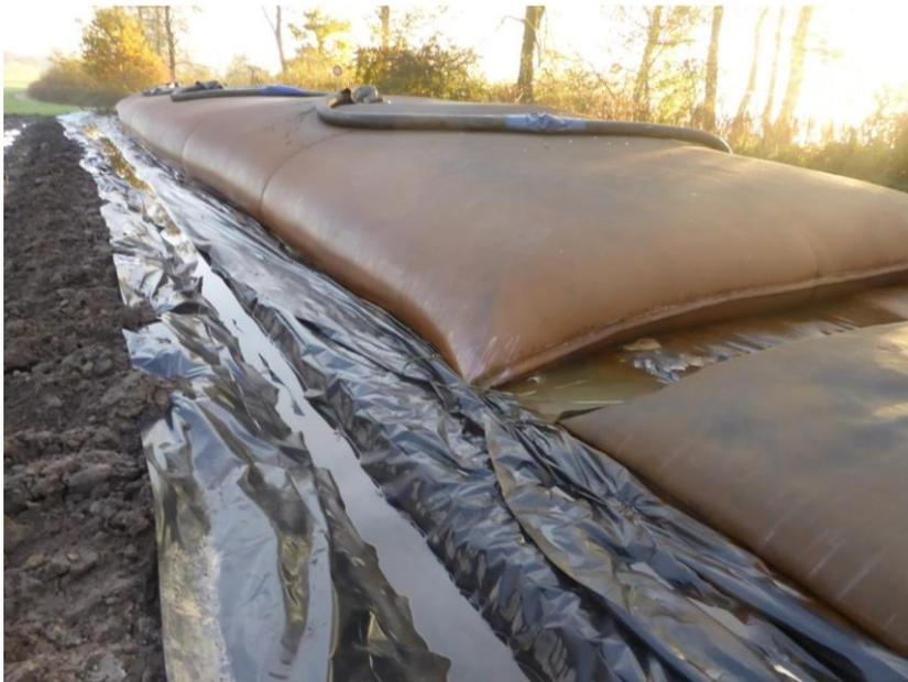
Abbildung 7: Anwendung von Geotubes im Rahmen des Versuchs 2014/15 (Foto: D. Schrag [2])
