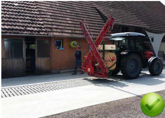
Quelle: AWEL ZH Füll- und Waschplatz, nicht überdacht
