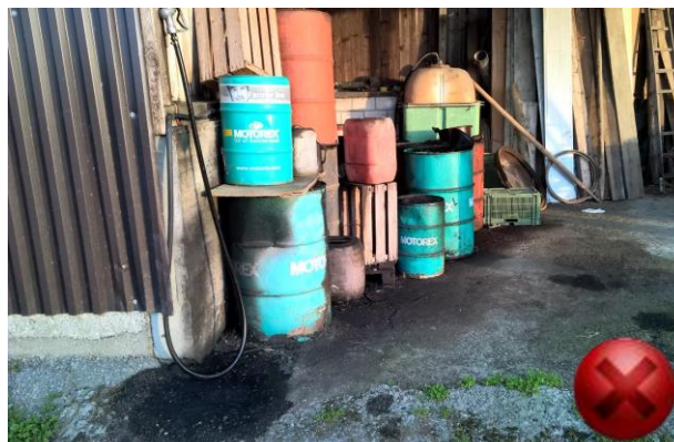
Quelle: AfU, SG Platz hat Löcher und Risse
