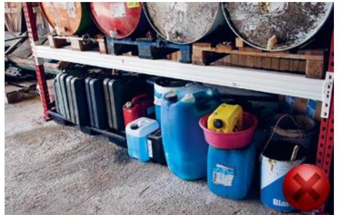
Quelle: AGRIDEA Keine Auffangwanne vorhanden und keine bauliche Massnahme verhindert Abfluss
