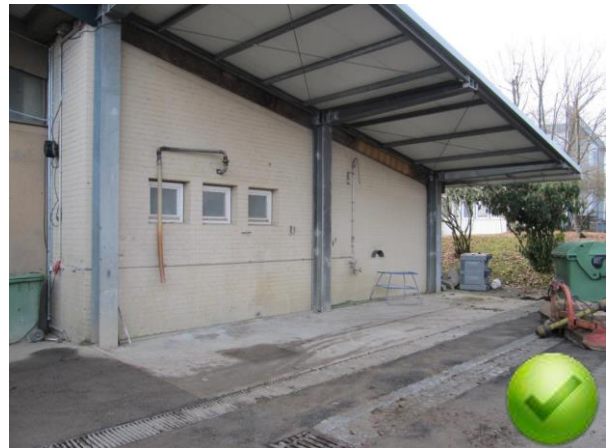
Quelle: AGRIDEA Füll- und Waschplatz, überdacht
