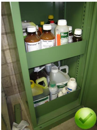
Quelle: AWEL ZH Lagerung in feuerresistentem, abschliessbarem Schrank für entzündliche Stoffe
