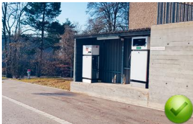
Quelle: KVV Dichter Betankungsplatz mit Entwässerung in Güllegrube
