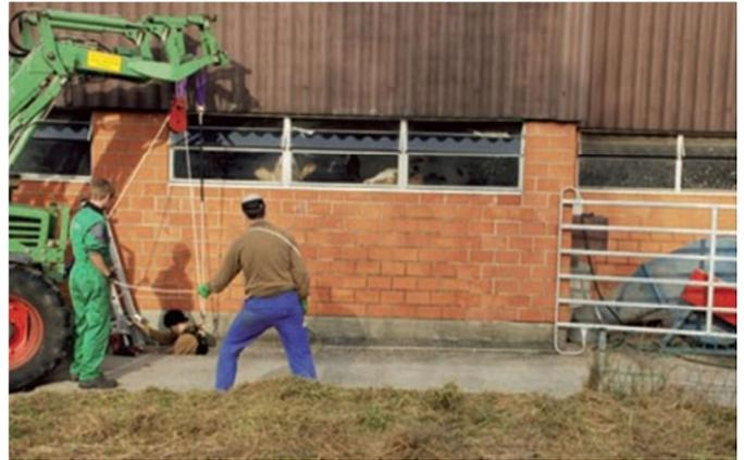
**Der Einstieg muss immer über eine sichere Leiter erfolgen. Auffanggurt, Umlenkung und Übersetzung des Sicherheitsseils sind zwingend nötig!** Der Einstieg ohne Durchlüftung der Grube ist nur möglich, wenn ein Frischluftgerät eingesetzt wird.
