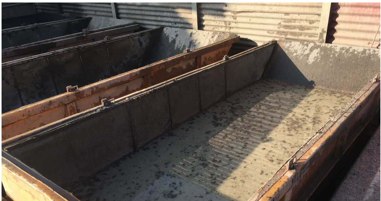
Absetzmulde für Schlämme aus dem Strassenunterhalt
