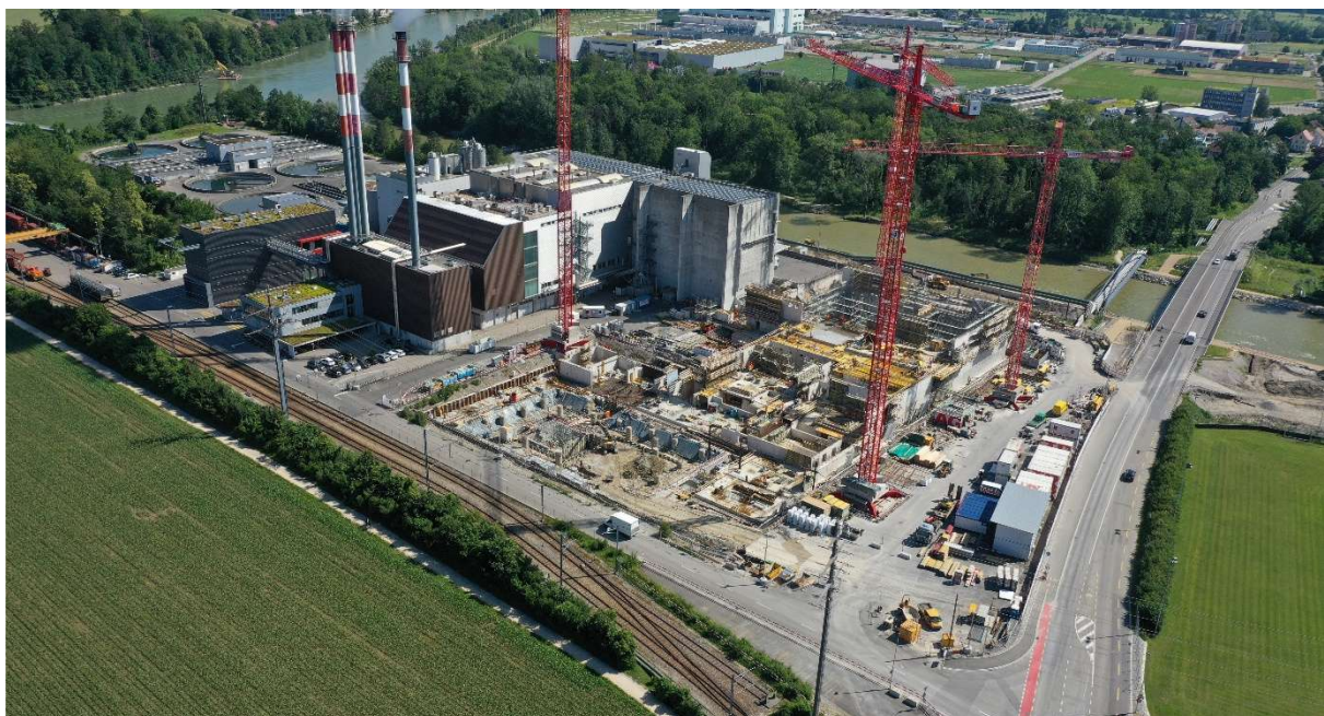
KEBAG AG im Emmenspitz mit der Baustelle der KEBAG ENOVA, Zuchwil (Blick von Südwesten)
