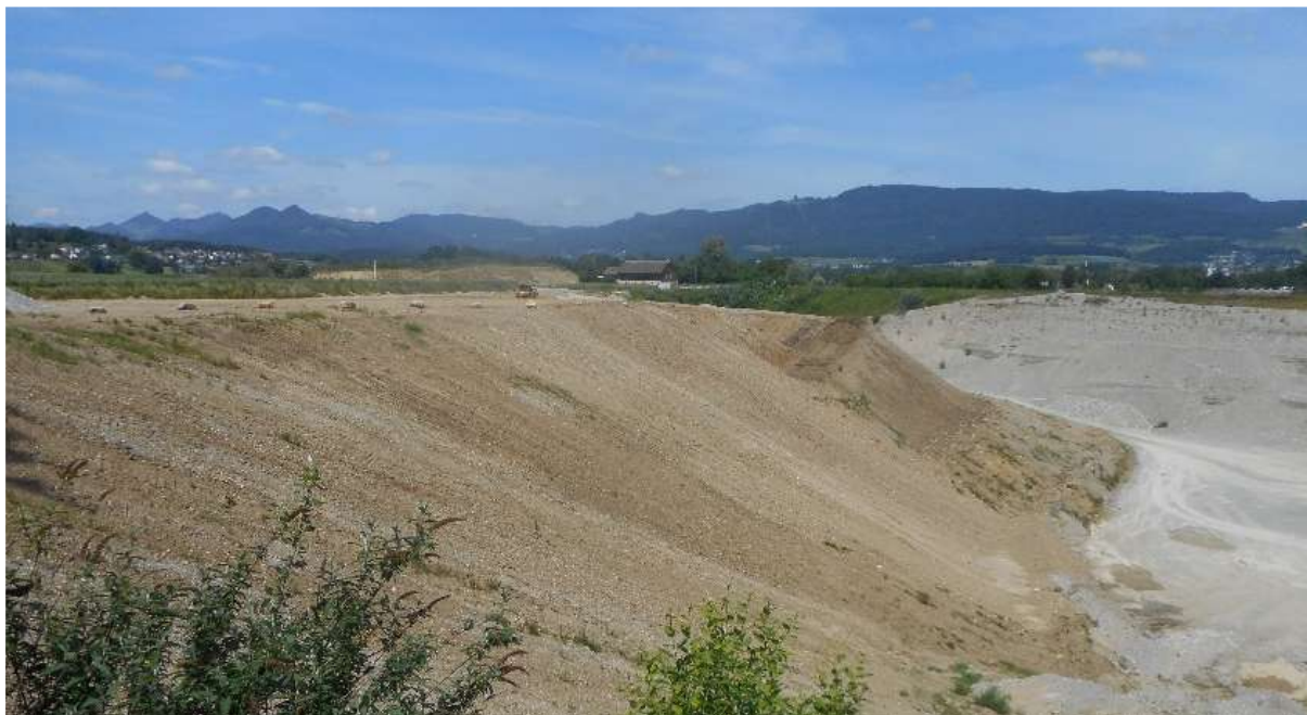
Wiederauffüllung der Kiesgrube Däniken mit unverschmutztem Aushubmaterial (Foto: AfU)
