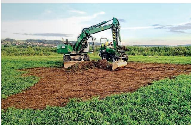
Flugzeugabsturz: Das versickerte Kerosin belastete den Oberboden, so dass der Boden ausgehoben und entsorgt werden musste.
