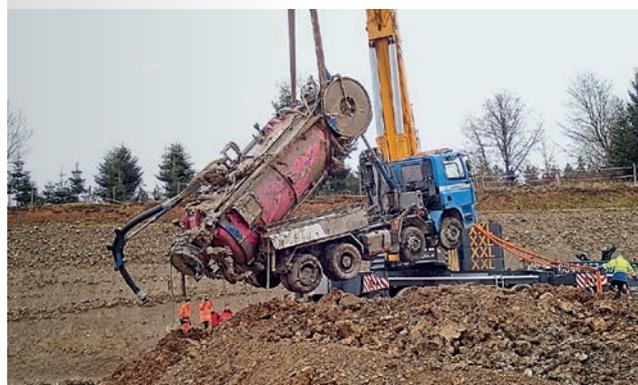
Nach einem Lastwagenunfall muss der Wagen geborgen und der durch Dieselöl verunreinigte Boden ausgehoben werden.
