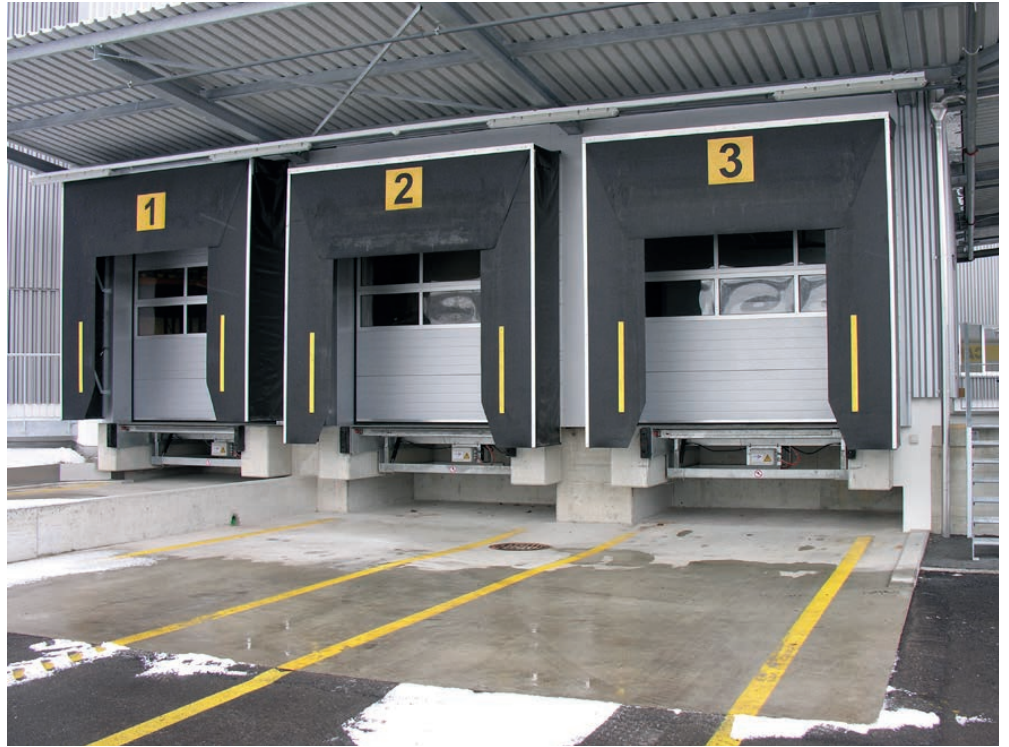
Abb. 5 Moderner Güterumschlagplatz mit Andockkrampen
