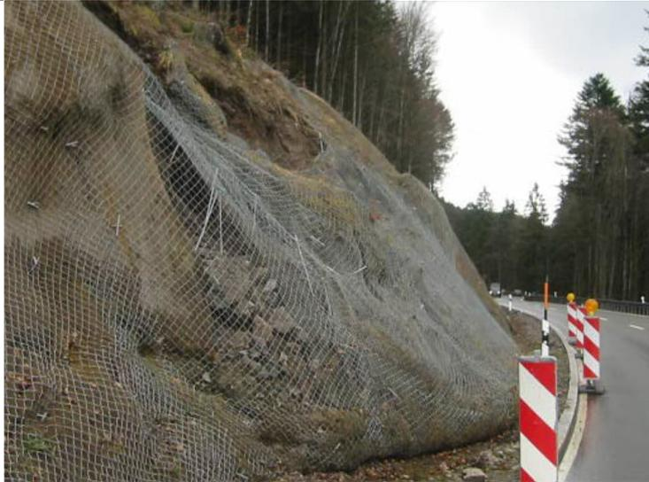
Abbildung 26: Rutschung unter Netzabdeckung, Beschädigung des Nagelrasters (Bild:[7])
