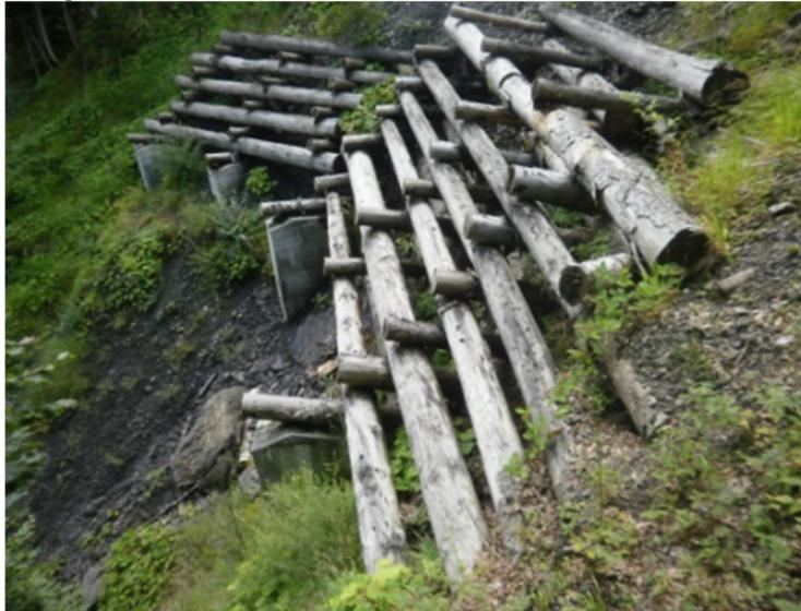
Abbildung 19: Freiliegender Holzkasten, Auswaschung des Lockermaterials und Faulstellen (Bild: [7])
