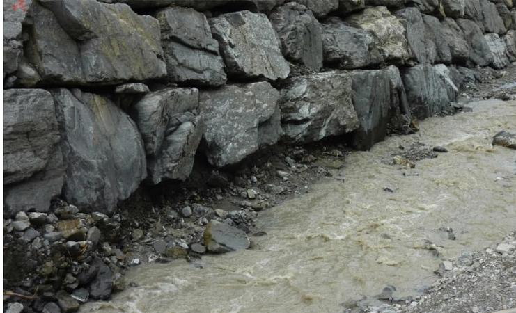
Abbildung 15: Lokale Unterspülung Blocksatz kann bei nächstem Hochwasser zur Gefährdung der Tragsicherheit führen.
