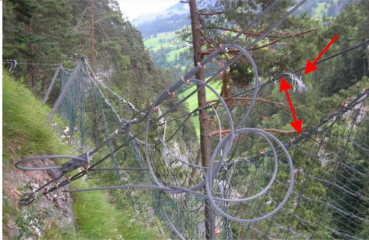
Abbildung 18: Durchhang Netz zu gross (rote Pfeile), verminderte Restnutzhöhe (Bild: [7])
