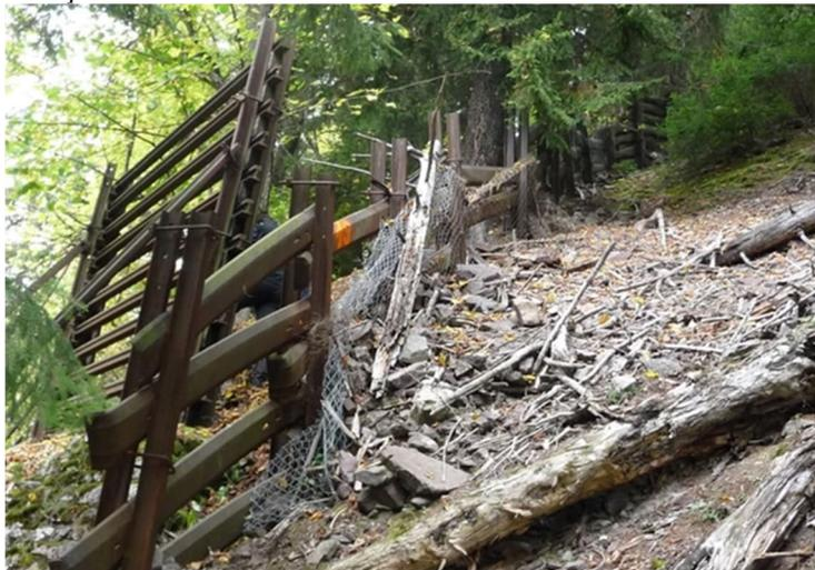
Abbildung 25: veralteter Steinschlagschutz / Palisade (Bild: RhB)
