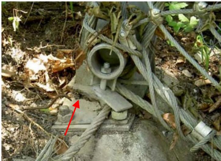
Abbildung 27: Gebrochene Grundplatte Foundation Steinschlagnetz (rote Pfeile), auswechseln (Bild:[7])
