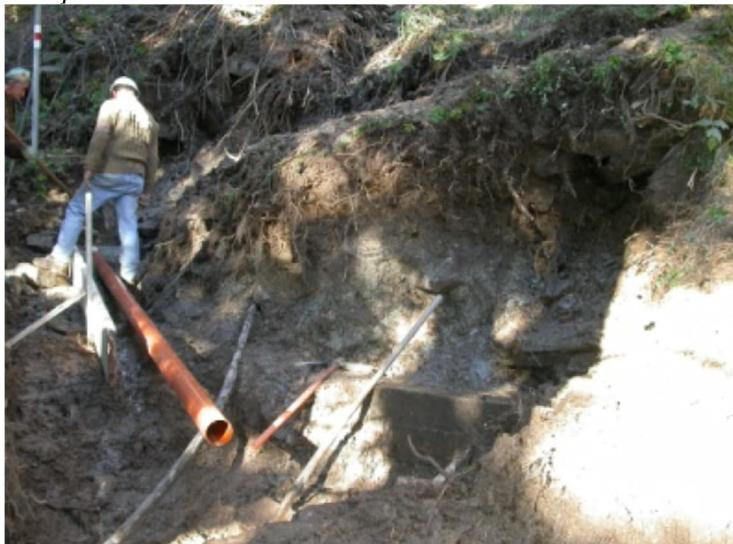
Abbildung 28: Beschädigtes Entwässerungssystem (Bild:[7])
