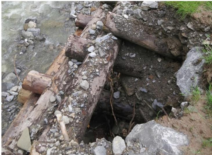
Abbildung 16: Lokale Auswaschung eines Holzkastens
