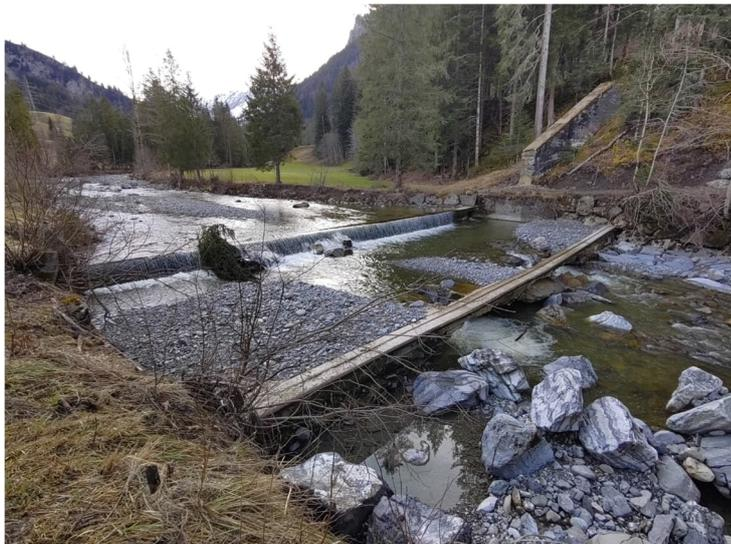
Abbildung 22: Zerstörte Sperre
