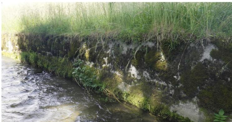
*Abbildung 14: Alterung und Bewuchs ohne Gefährdung der Tragsicherheit*
