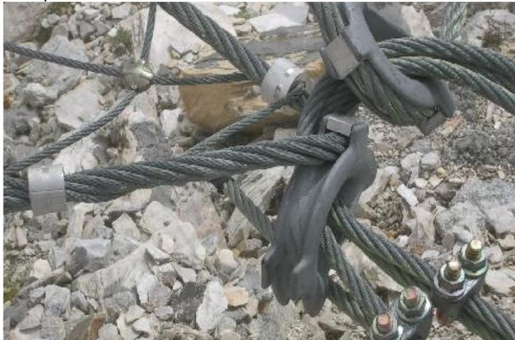
Abbildung 17: Verdrehte oder beschädigte Netzrandkouschen (Bild: [7])
