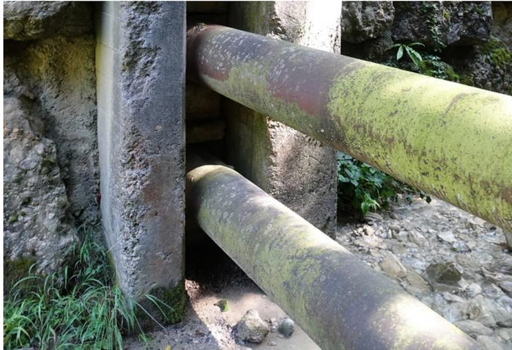
*Abbildung 12: Betonabplatzungen ohne Gefährdung der Tragsicherheit*
