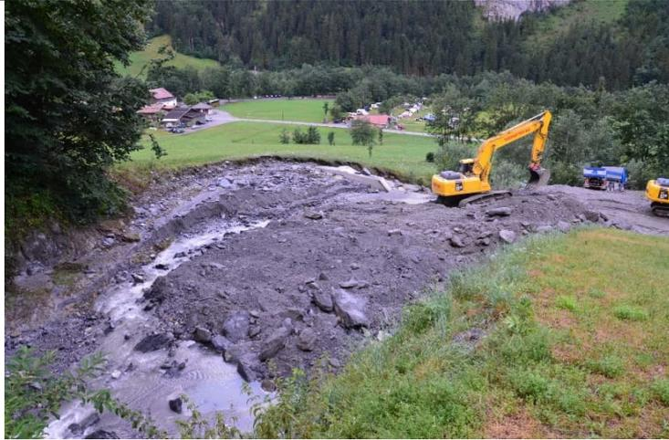
Abbildung 23: Vollständig verfüllter Geschiebesammler (Bild: David Baumann)
