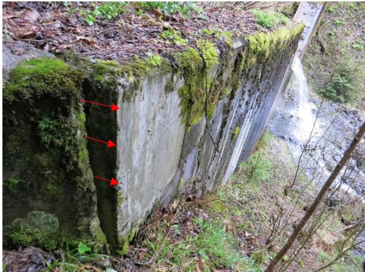
Abbildung 21: Talwärts verkippte Betonsperre (rote Pfeile)
