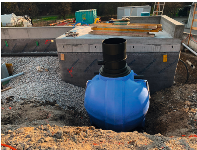
Ein unterirdischer Rückhaltetank muss zwingend doppelwandig und frostsicher sein, Ripalco AG.
