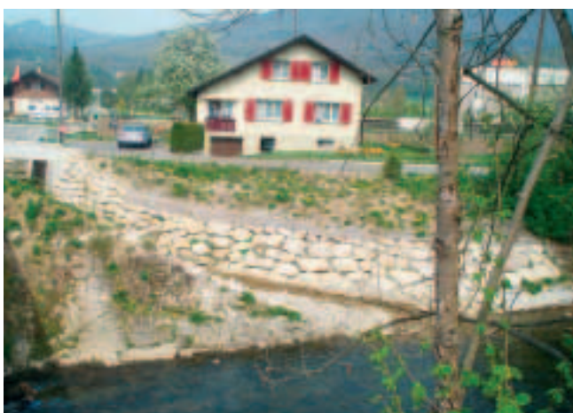
Die neue Fischrampe.
