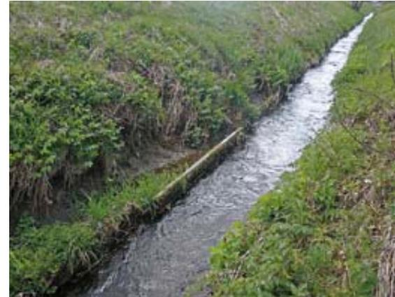
Die eingebauten Betonelemente sind teilweise baufällig – eine Wiederherstellung wäre kostenintensiv und nicht mehr gesetzeskonform.
