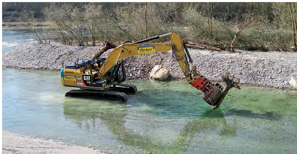
Einbau von Kleinstrukturen.
