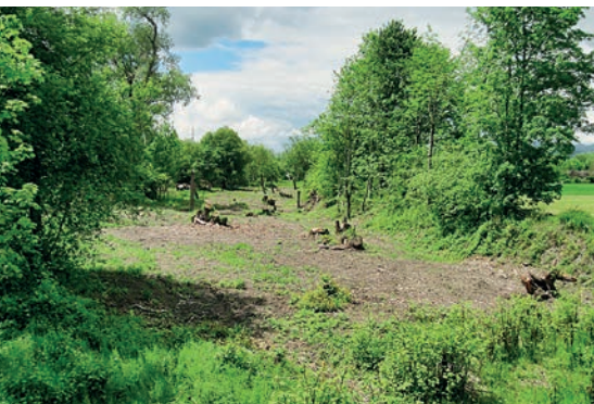
Das neue Seitengerinne braucht Platz. Viele Baumstrünke und die Walderde werden im Projekt weiterverwendet.
