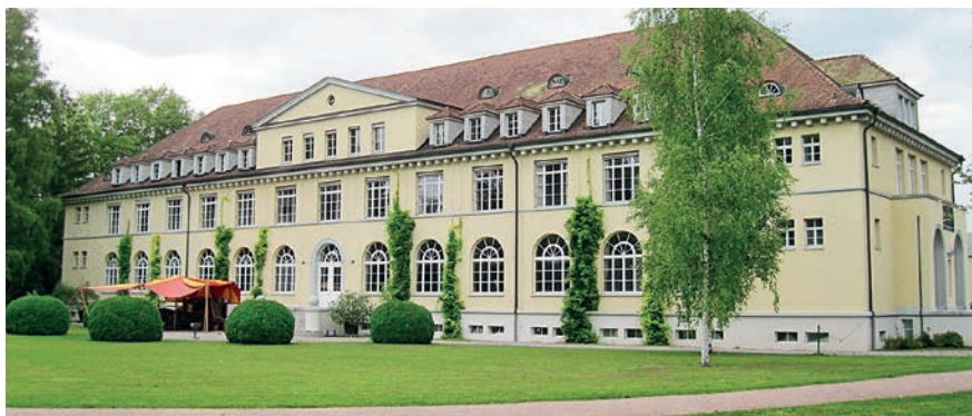
Das Kosthaus, eine soziale Einrichtung von Bally-Patron Carl Franz Bally, wurde 1919 eingeweiht. Heute dient es unter anderem als Event-Location.
