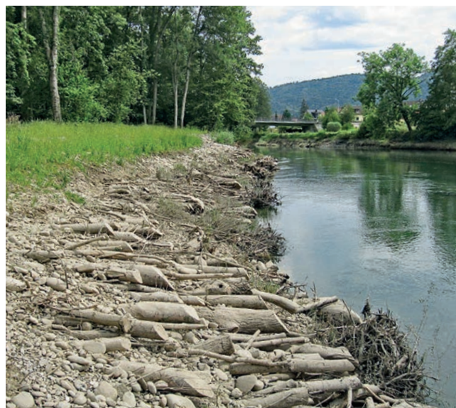
Gerodete Fläche im Giriz. Die noch stehenden Baumstämme werden im Los 4 als Ufersicherung eingebaut (Bild rechts: ingenieurbioologische Massnahmen an der Aare).
