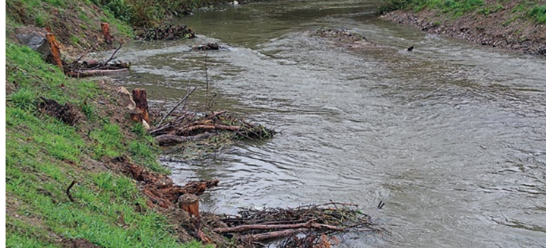
Heute fliesst die Emme im Emmenschachen in einem engen Korsett. Neu wird ein ungesichertes, mit Baumbuhnen strukturiertes Ufer angelegt. Dadurch kann die Emme ihr Ufer selber gestalten.
