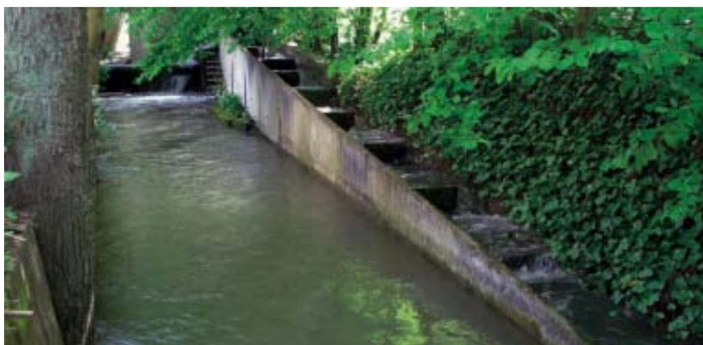
*Fischpass am Kleinwasserkraftwerk Mühle Derendingen (Foto: S. Gerster)*
