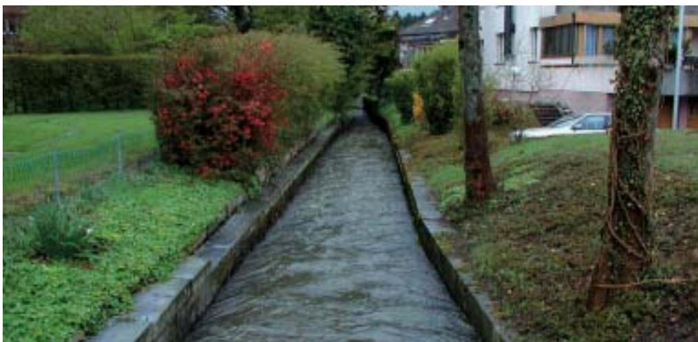
*Zeuge einer überholten Wasserbau-Philosophie. Eingeengtes und kanalisiertes Gerinne der Kleinen Oesch in Derendingen. (Foto: AfU SO)*
