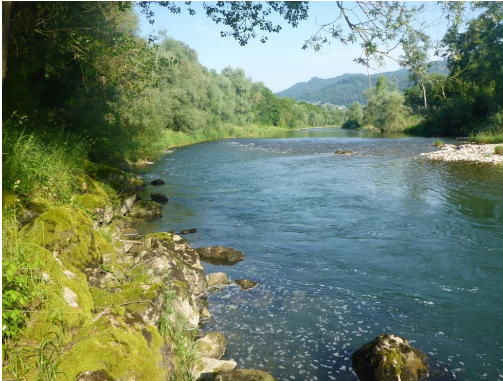
Abb. 16 Blockwurfverbauung am rechten Ufer bei Winznau (Strecke U2). Die Befischungsstrecke lag im Übergangsbereich einer Furt (oben links) Lauf (unten rechts) und Kolk (weiter flussabwärts, auf dem Bild nicht sichtbar). Der Blockwurf ist unregelmässig angeordnet, so dass Unterstände und Stillwasserzonen entstehen. Foto J. Guthruf.
