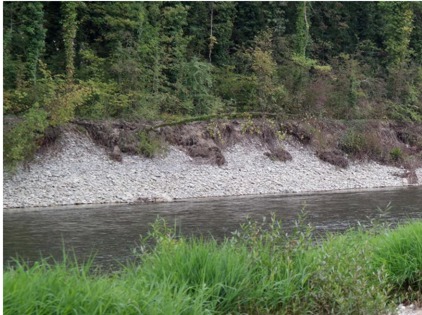
Abbildung 2-8: Steilufer auf der rechten Flussseite in der Untersuchungsstrecke U7 Wöschnau (Foto: Fischwerk 18.09.2014)
