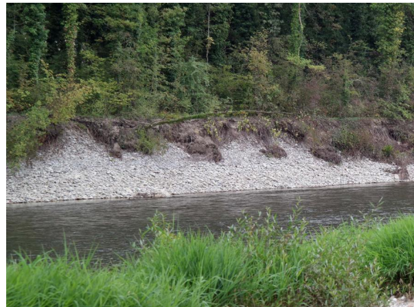
Abbildung 8-6: Steilufer auf der rechten Flussseite in der Untersuchungsstrecke U7 Wöschnau (Foto: Fischwerk 18.09.2014)
