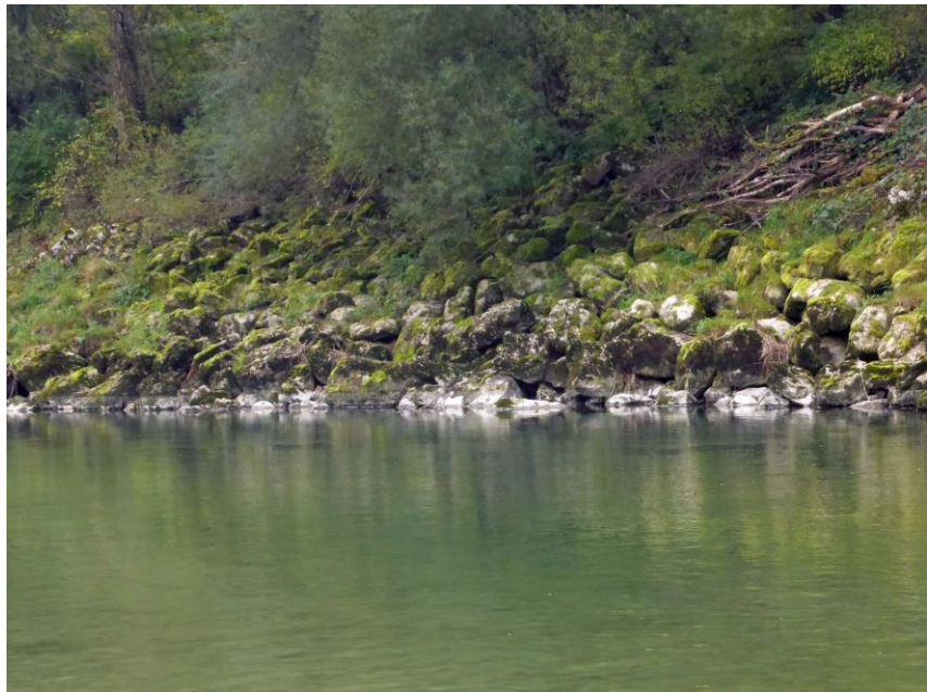
Abbildung 2-5: Verbautes rechtes Ufer in der Untersuchungsstrecke U2 Winznau (Foto: Fischwerk, 30.11.2014)
