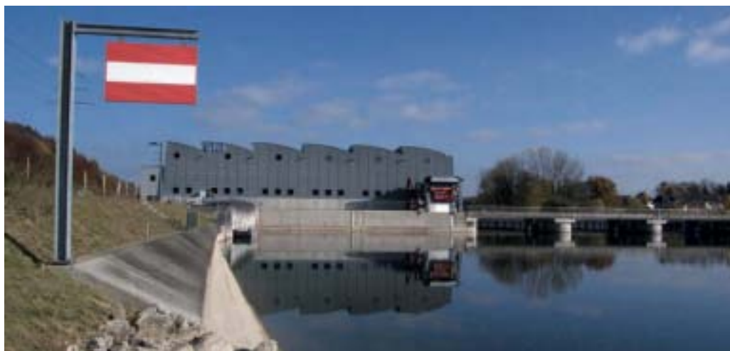
Kraftwerk Ruppoldingen (Foto: creato)
