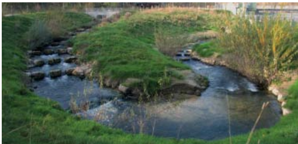
Raugerinnefischpass Wehr IBAarau (Foto: creato)
