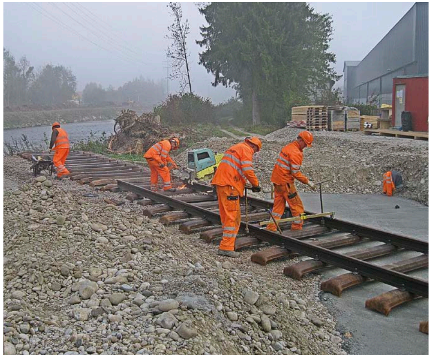
Bau des neuen Verladegleises
