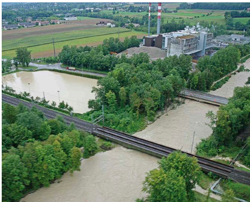
Hochwasser 2007 – Überflutung im Bereich Fussballplatz Scintilla, Zuchwil
