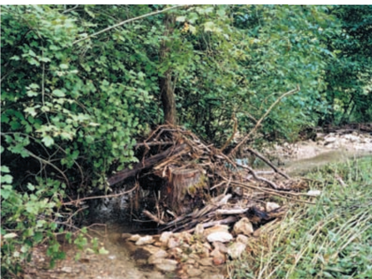
Foto eines nicht nachgeschnittenen Stockes mit Holzverkläusungen nach Hochwasser (HW)
