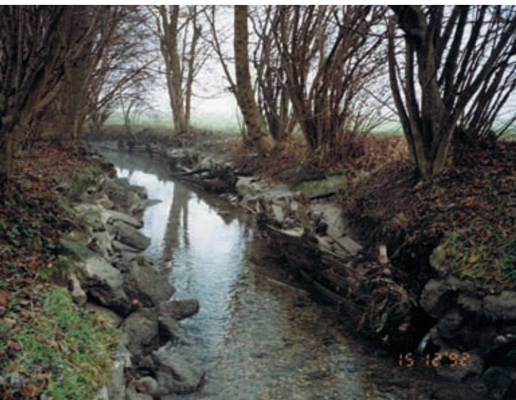
vor der Revitalisierung am 15. 12. 1992
