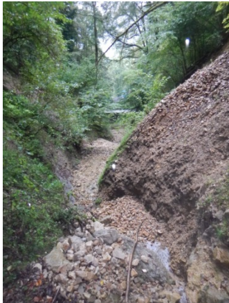
Foto 1: Geschiebesammler Rütelibach in Fließrichtung
