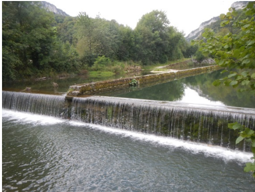
Foto 1: Geschiebesammler in der Klus von Balsthal. Blick entgegen der Fließrichtung
