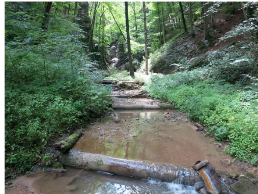
Foto 2: Holzschwellen oberhalb der Eindolung (Blick bachaufwärts)
