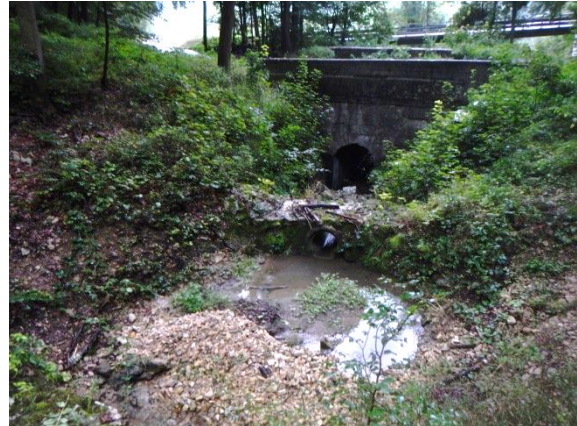
Foto 2: Geschiebesammler Rütelibach in Fließrichtung
