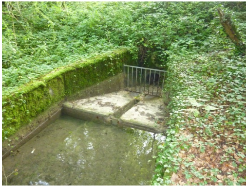
Foto 1: Geschiebesammler mit Blick in Fließrichtung
