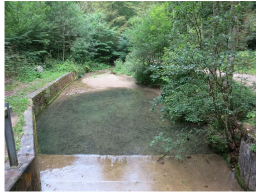
Foto 2: Ablagerungsraum (Blick entgegen Fließrichtung)
