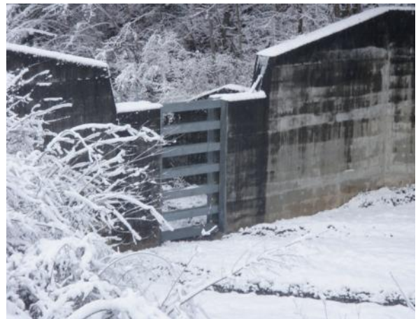
Abbildung 4: Geschlossener (links) und offener (rechts) Geschiebesammler. Als geschlossene Sammler gelten auch Konstruktionen mit kleinen Öffnungen. Quelle: [1].
