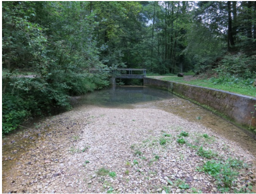
Foto 1: Ablagerungsraum (Blick in Fließrichtung)
