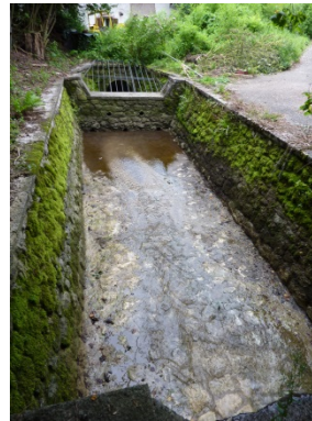
Foto 2: Geschiebesammler mit Blick in Fließrichtung
