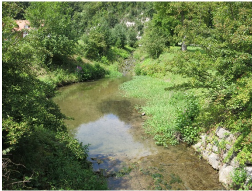
Foto 1: Geschiebesammler mit Aufweitung und Schwelle (Blick stromaufwärts)
