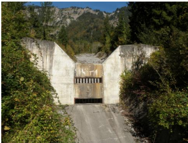
Abbildung 4: Geschlossener (links) und offener (rechts) Geschiebesammler. Als geschlossene Sammler gelten auch Konstruktionen mit kleinen Öffnungen. Quelle: [1].
