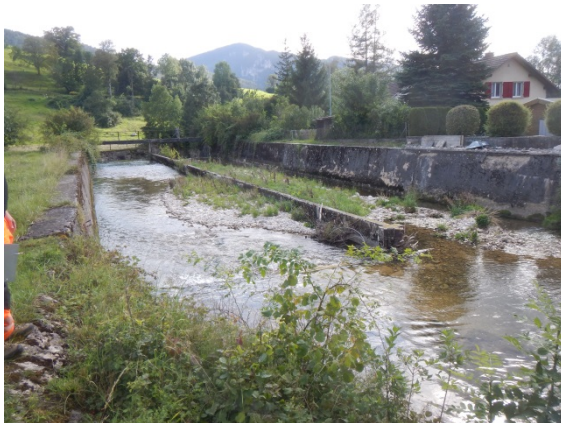
Foto 1: Geschiebesammler Mümliswilerbach vor der Mündung in den Augstbach. Blick in Fließrichtung
