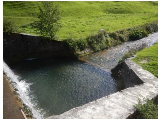
Foto 2: Tosbecken des Geschiebesammlers Alt Berg im Augstbach. Blick in Fließrichtung
