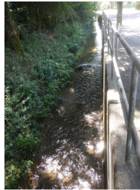
Foto 2: Kanalisiertes Gerinne unterhalb der Entnahmestelle mit Blick in Fliessrichtung
