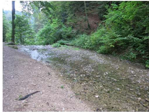
Foto 2: Hinterfüllte Sperre (Blick in Fließrichtung)
