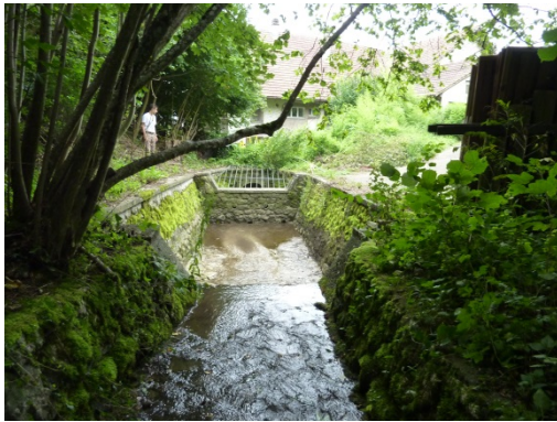
Foto 1: Geschiebesammler mit Blick in Fließrichtung
