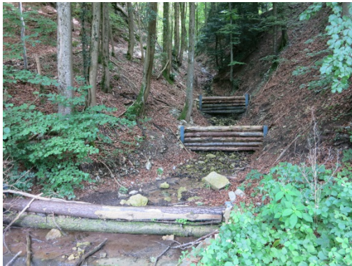
Foto 1: Drei Holzsperrn oberhalb der Strasse (Blick bachaufwärts)
