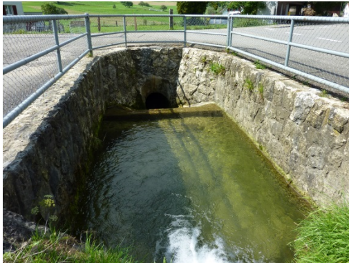
Foto 1: Geschiebesammler mit Blick in Fließrichtung
