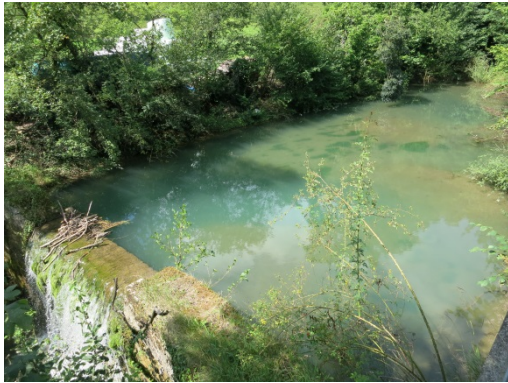
Foto 1: Geschiebesammler mit Abschlussperre
