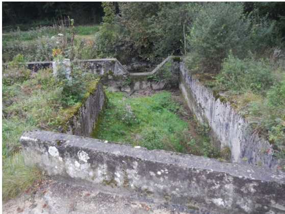
Foto 1: Geschiebesammler Musbächli vor der Mündung in den Augstbach. Blick in Fließrichtung
