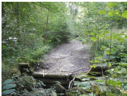
Foto 1: Geschiebesammler Bals_Stein_01 oberhalb der Felsstufe im Waldbereich. Blick entgegen Fließrichtung
