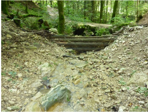
Foto 1: Geschiebesammler mit Blick in Fließrichtung
