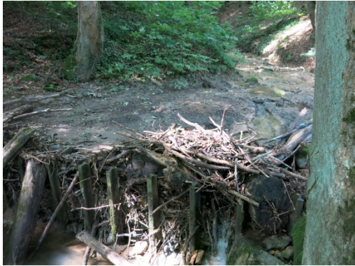
Foto 1: Rechen mit Schwemmholt- und Geschieberückhalt
