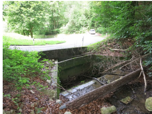
Foto 2: Geschiebeabsetzbecken direkt oberhalb der Strasse
