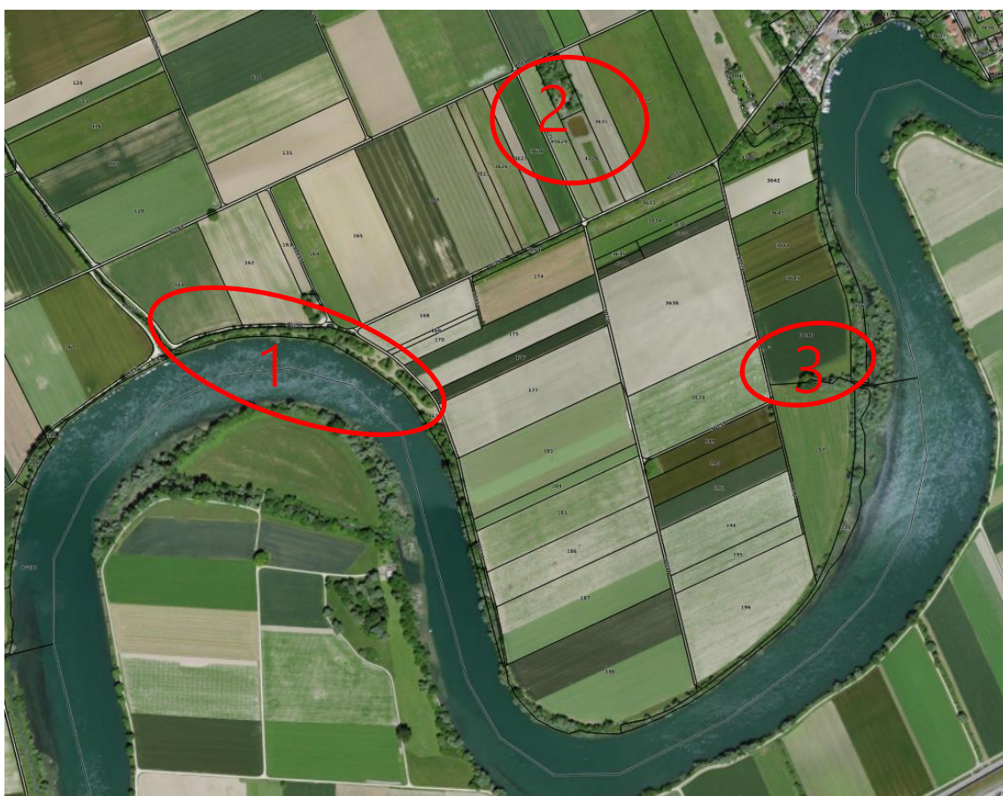
Abbildung 3 Luftbild und nähere Umgebung der Projektperimeter, geo.so.ch am 15.02.2023
