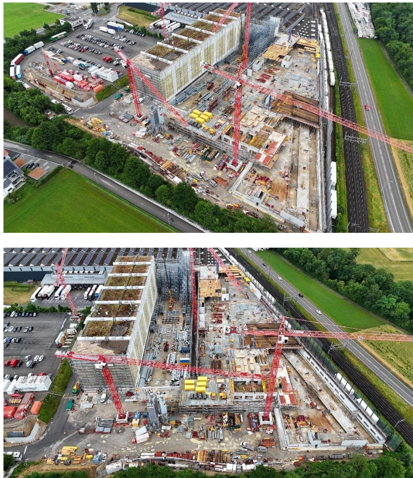
Abbildung 12 Sofortmassnahme West in Realisierung (Stand Juni 2025)
