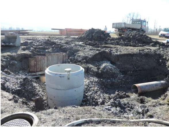
Brunnenschacht gesetzt, Drainagerohr muss repariert werden (22.2.2019)
