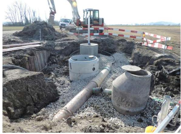
Von hinten: Fundament Solarpanel, Brunnenschacht, Schlamm-sammler von Tümpelablass (26.2.2019)
