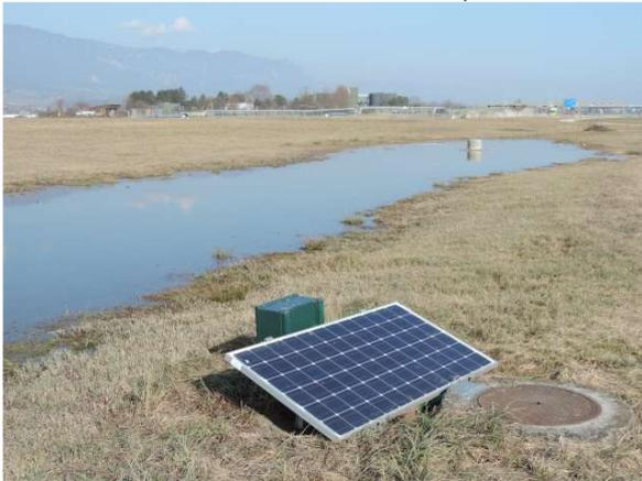
Speisung mit Solarpumpe aus Drainageschacht (16.2.2017).
