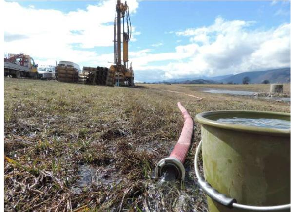
Brunnenrohr gesetzt, Pumpversuch (12.3.2018).
