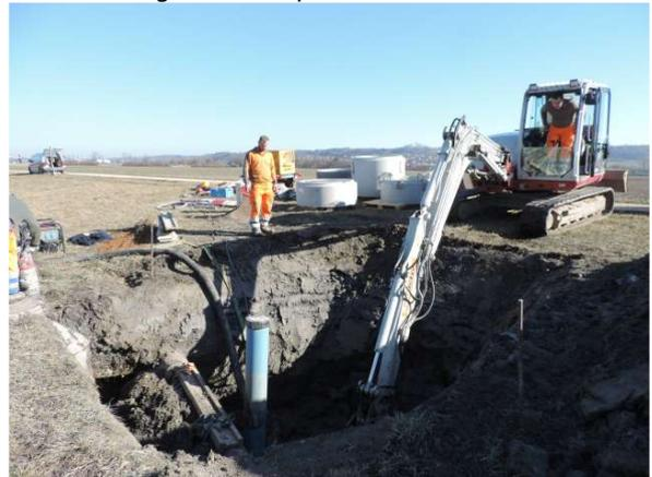
Wasser dringt ein, die Baugrube für den Brunnenschacht droht einzustürzen (18.2.2019).
