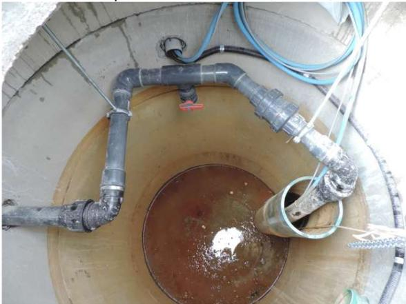
Brunnenschacht mit Brunnenrohr, Wasserleitung und Stromkabel für Pumpe (6.5.2019)
