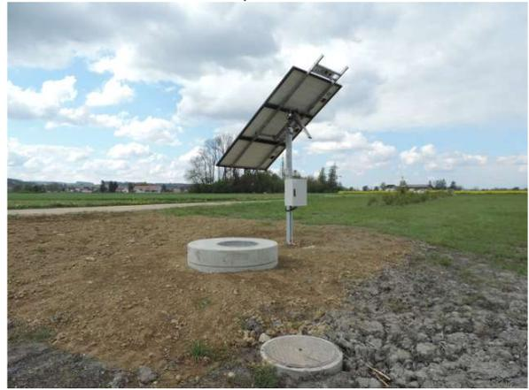
Solarpanel mit Schalterkasten montiert (6.5.2019)
