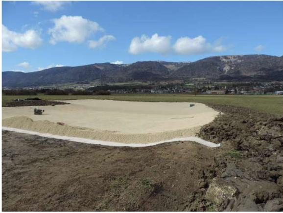
Aufbau der Abdichtung: Planum – Bentonitmatte – Deckschicht 30 cm (12.3.2021)
