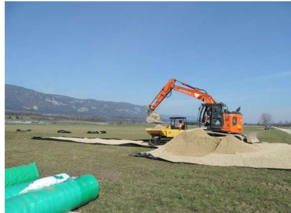
Mergelzwischenlager und Baupiste, Mergeltransport mit Raupendumper (9.3.2021)
