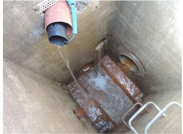
Spülung ohne Niveau-Schwimmerschalter: Notüberlauf (oberes Rohr) in Drainageschacht (29.3.2021)
