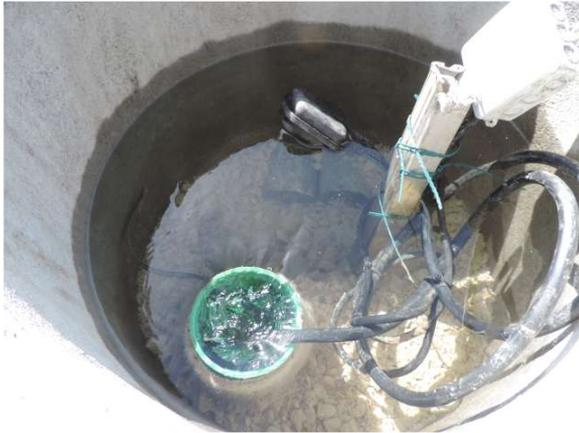
Spülung ohne Niveau-Schwimmerschalter: Abfluss durch Notüberlauf (grünes Rohr) in Drainage (29.3.2021)
