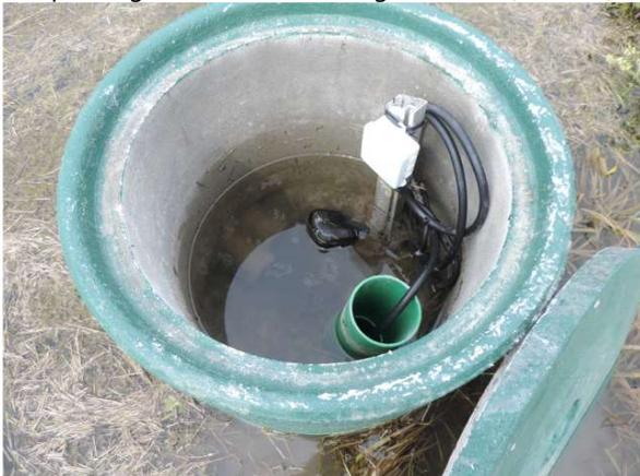
Schacht mit Niveau-Schwimmerschalter (18.5.2017).
