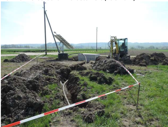
Pumpleitung wird am Brunnen angeschlossen (7.4.2017).
