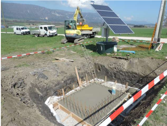
Der Brunnenschacht wird betoniert (28.3.2017).
