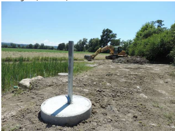
Fundament für das Solarpanel (20.6.2018)
