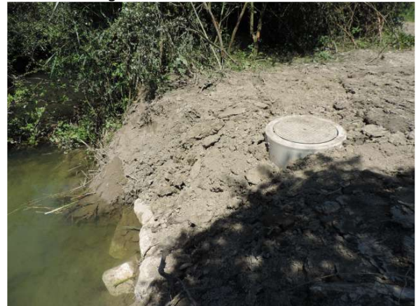
Der Pumpenschacht ist gebaut (20.6.2018).
