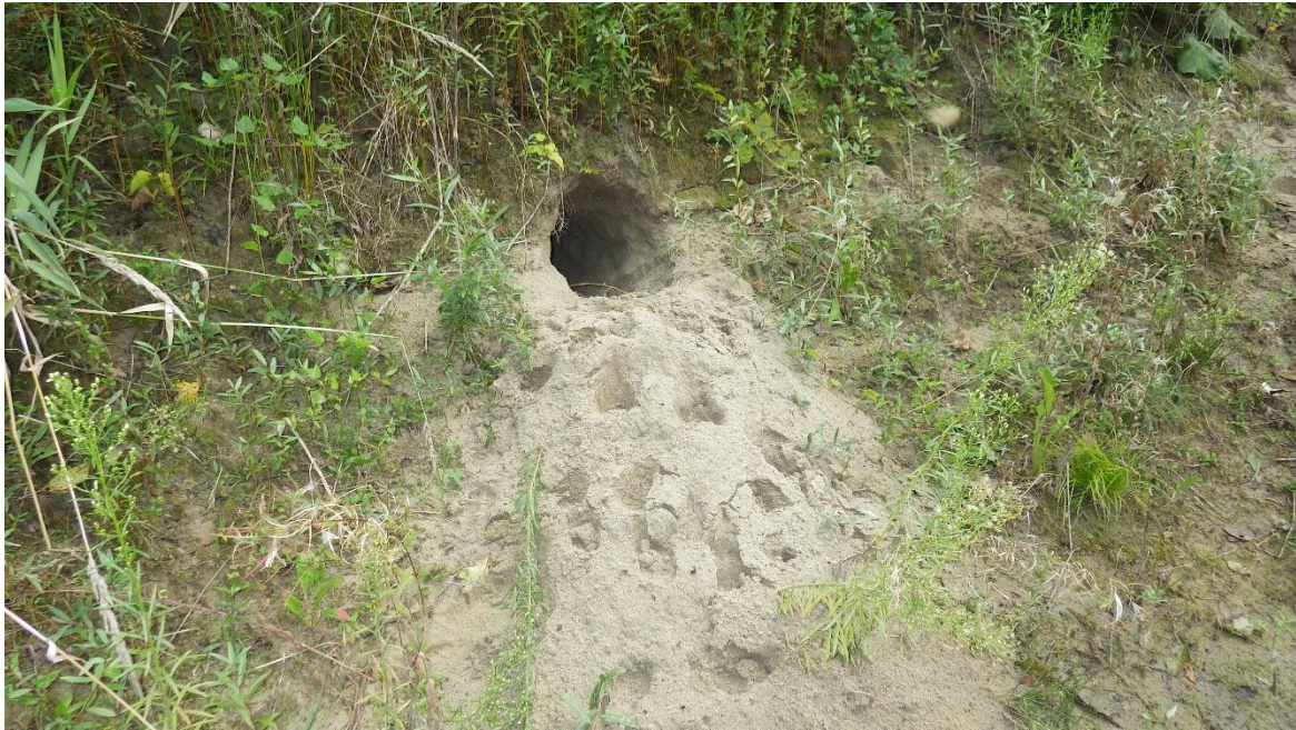
Abb. 8: Im Damm hat ein Fuchs mindestens fünf Löcher gegraben
