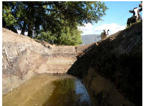
Baggersondierung: Das Grundwasser steht in 2 m Tiefe.
