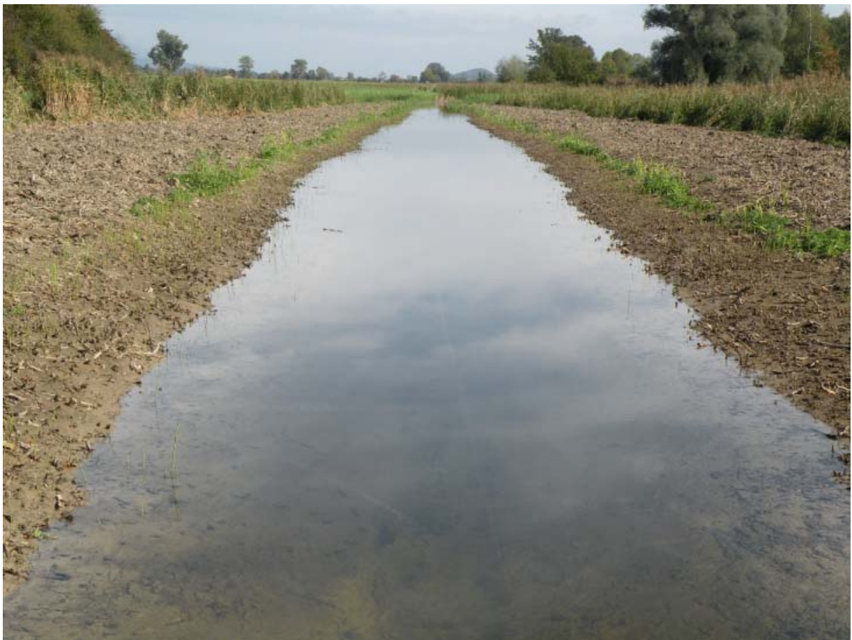
Neuer Riedgraben im Altwasser an Stelle eines Betonrohrs
