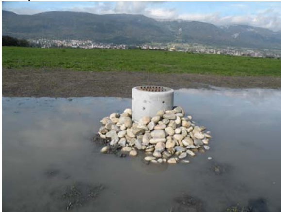
Ablaufsystem mit regulierbarem Standrohr.
