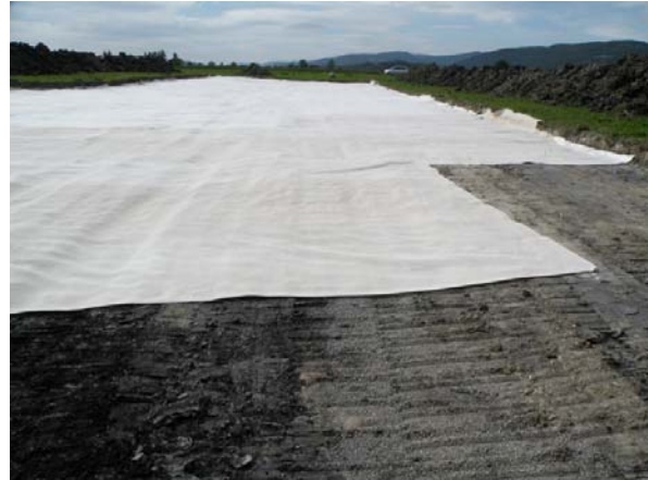
Bauphase: Verlegen der Bentonitmatten.
