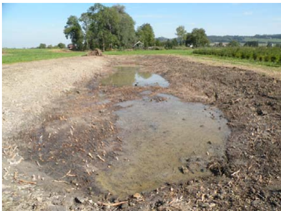
Der östliche Weiher nach der Instandstellung.
