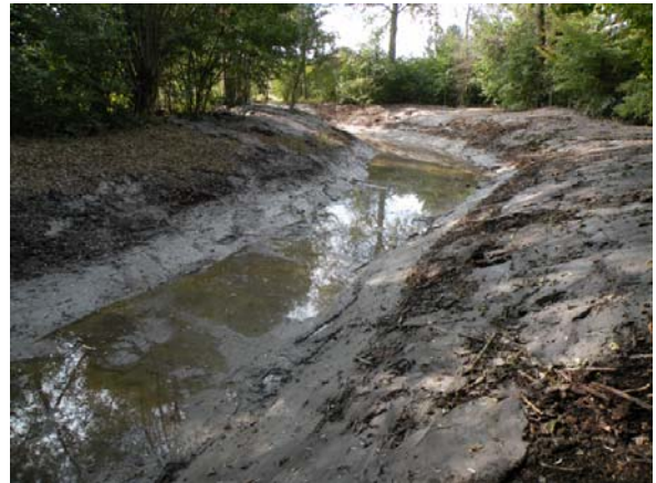
Während der Instandstellung. Die Auslichtung des Gehölzes steht noch bevor.
