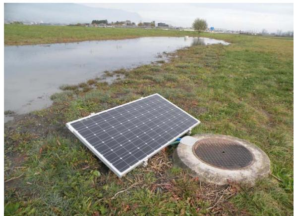
Elektropumpe mit Solarmodul
