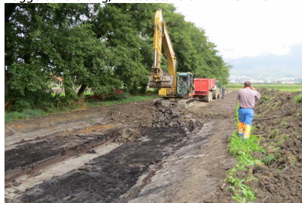
Aushub mit Sohle auf 110 cm Tiefe, flachen Böschungen und einem zentralen Gräblein von weiteren 50 cm Tiefe (28.8.2013).
