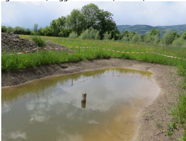
Altwasser, Baggerschlitz Ost (24.5.2013)
