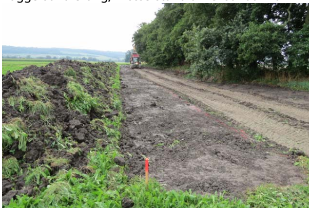
Der Oberboden (10 cm) wird abgetragen und zwischengelagert für eine Wiederverwendung (28.8.2013).
