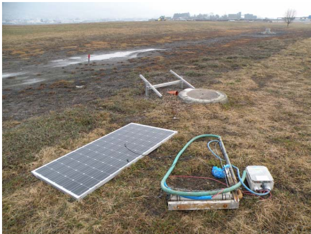
Montage der Solarpumpe im bestehenden Schacht der Drainage-Hauptleitung (8.3.2013).
