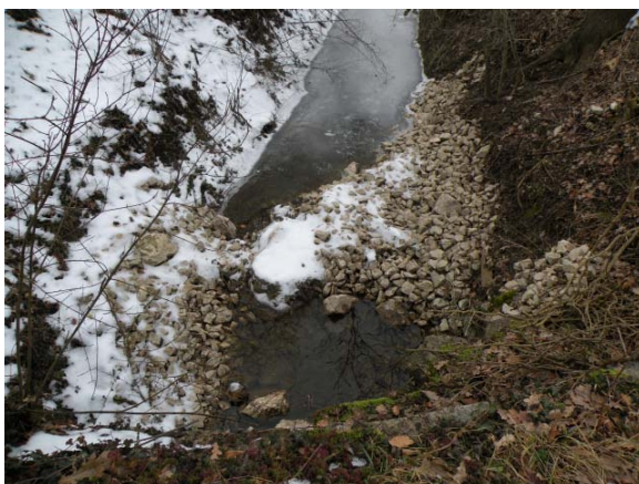
Die Fischsperre aus Schroppen im Hölzligaben (24.1.2013) wurde auf Wunsch des Eigentümers wieder entfernt.
