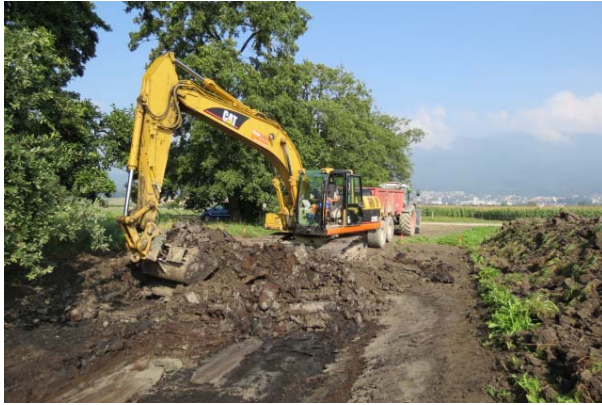
Gleyboden mit geringen Torfhorizonten, rechts das Oberboden-Depot (29.8.2013).
