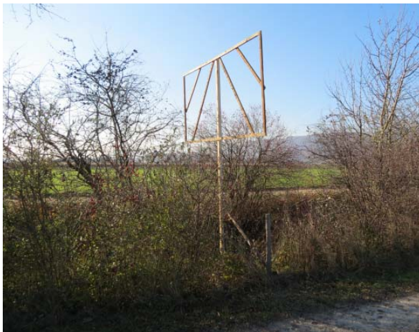
Das Bauprofil steht (27.11.2013).
