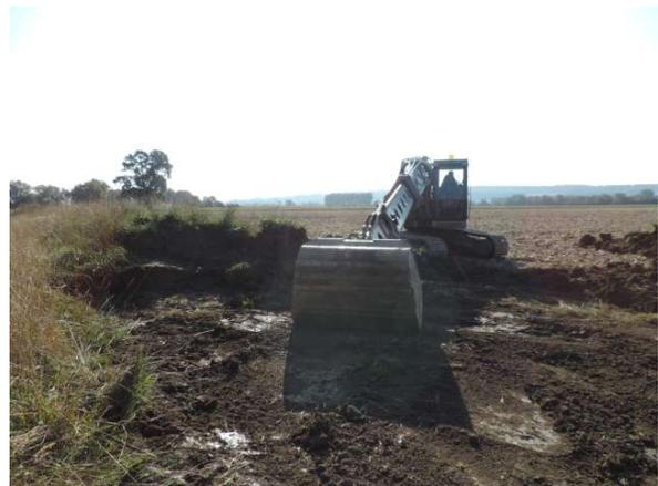
Das überschüssige Oberbodenmaterial von 2014 wird ab Zwischenlager auf der benachbarten Parzelle ausgebracht (5.8.2015).
