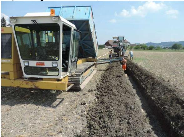
Bei trockenem Boden wird das neue Drainagerohr verlegt und eingekiest (12.8.2015).
