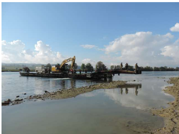
Mit einem Brückenelement bringt das Pontonier-Bataillon 26 einen Bagger der Armee auf die Insel (18.10.2016).
