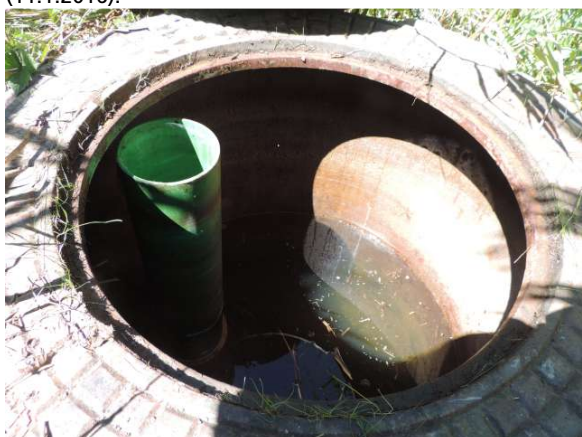
Das Standrohr wird gezogen, der Graben trocken gelegt (23.8.2016).
