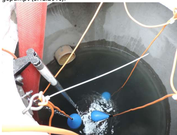
Die Niveau-Schwimmerschalter werden eingestellt (20.12.2016).
