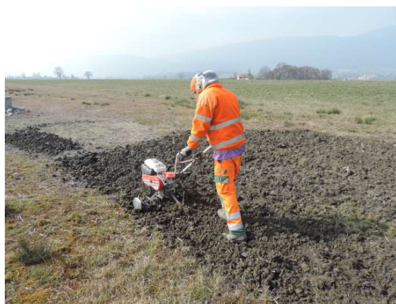
Die stark verschilften Bereiche werden gefräst.
