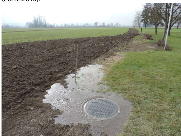
Das Wasser läuft nun nicht mehr in den Keller, sondern wird neben dem Haus über die Oberfläche versickert (20.12.2016).
