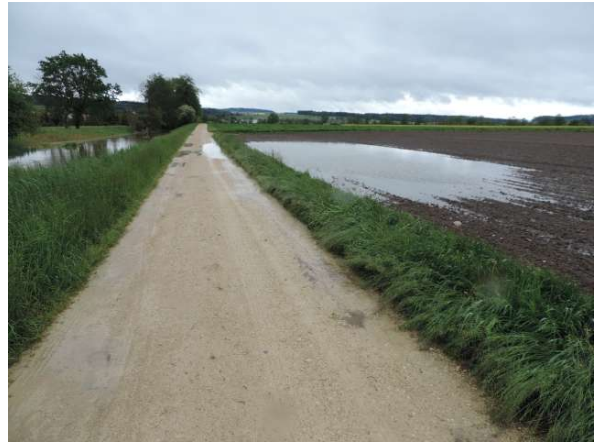
Staadkanal im Bereich Egelsee, auch westseitig mit Überschwemmung.
