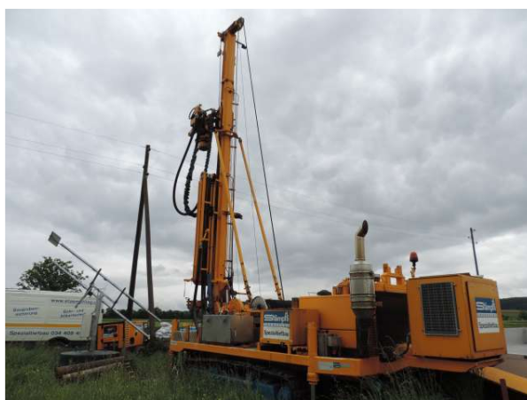
Der Naturschutz beschreitet neue Wege. Zur Speisung der Storchenwiese wird ein 25 m tiefer Grundwasserbrunnen gebohrt (23.5.2016).
