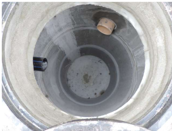
Falls es wieder zu einem Rückstau der Drainage kommt, wird das Wasser aus dem neuen Pumpschacht aufs Feld gepumpt (8.12.2016).
