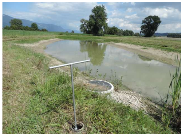
Der Schieber der südlichen Flutmulde wurde geöffnet (10.8.2016).
