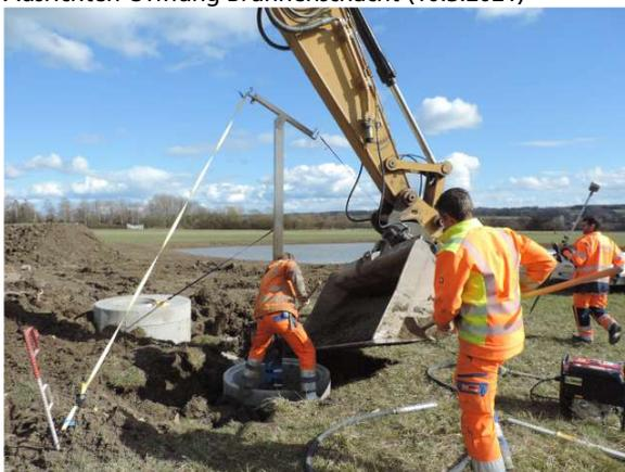
Giessen Beton Mastfundament (12.3.2021)
