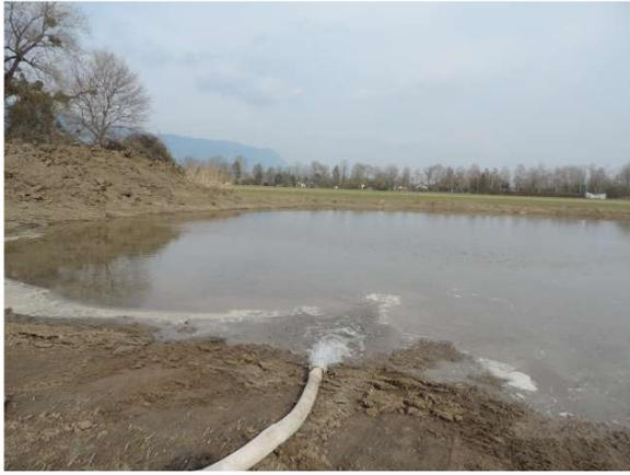
Dichtigkeitstest Flutwiese mit Motorpumpe (9.3.2021)
