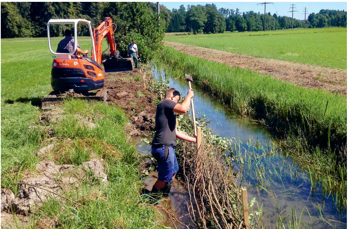
Naturnahe Uferverbauung (Wolfwil)
