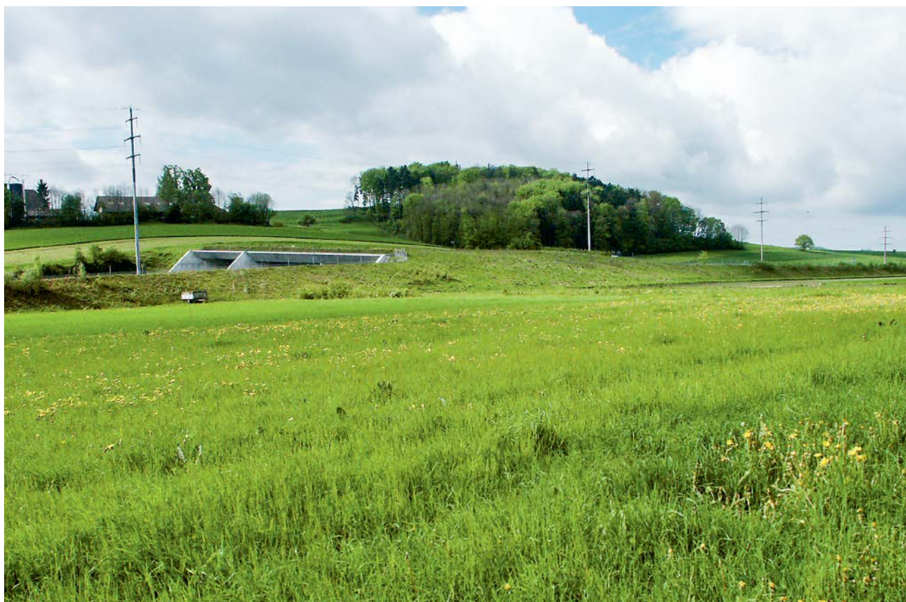
Wildtierbrücke zur Querung der A5 (Lüsslingen-Nennigkofen)
