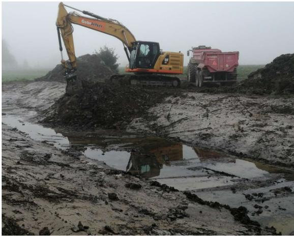
Aushub mit langsam eindringendem Schichtwasser (27.10.22)
