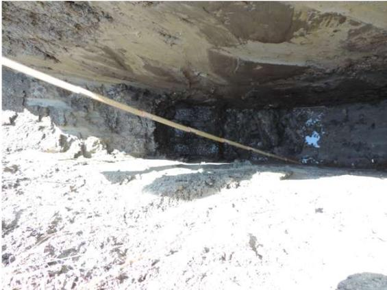
Baggerschlitz mit eindringendem Schichtwasser (24.6.21)
