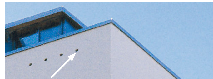
Fertiggestellter Neubau mit eingebauten Seglernistplätzen.
