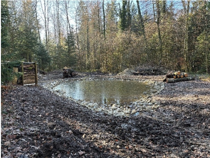
Abb. 2: Der neue Dickeliweiher ist grösser als vorher, ablassbar und begehbar. Die bestellten Bollensteine wurden als formwildes Material unterschiedlicher Grösse geliefert. Sie wurden alle von Hand eingelegt und fest ineinander verkeilt.
