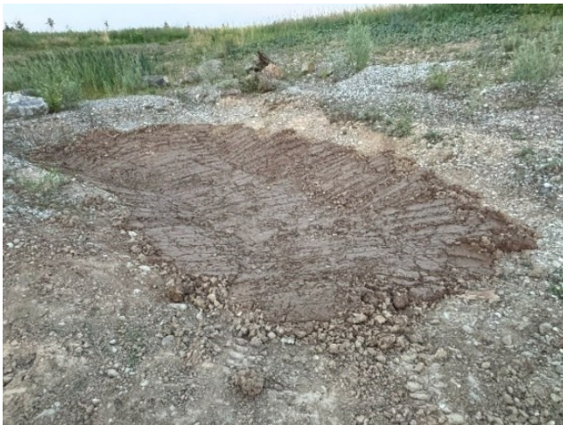
Abb. 1: Kurz vor der Hitzeperiode im Juni wurde einer der trockenen Tümpel neu mit Lehm ausgestrichen, aber erstens viel zu dünn, zweitens nicht verdichtet mit Ramax oder Vibroplatte, auch nicht glattgestrichen mit Wasser, und geschweige denn mit Wasser gefüllt.
