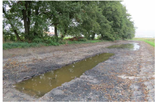
Die Überflutung der Sohle ist sehr variabel; nur die drei tieferen, zentralen Gräblein führen permanent Wasser.
