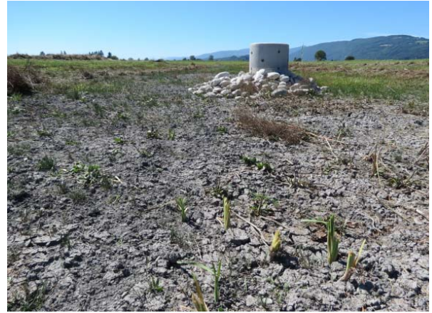
Abfluss mit Schacht und Standrohr.
