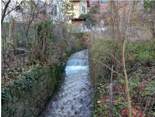
Abbildung 13: Überfall bei m 1456.37, h ca. 0.75 m und beim Überfall querende Swisscom / TV-Leitung (rechts)
