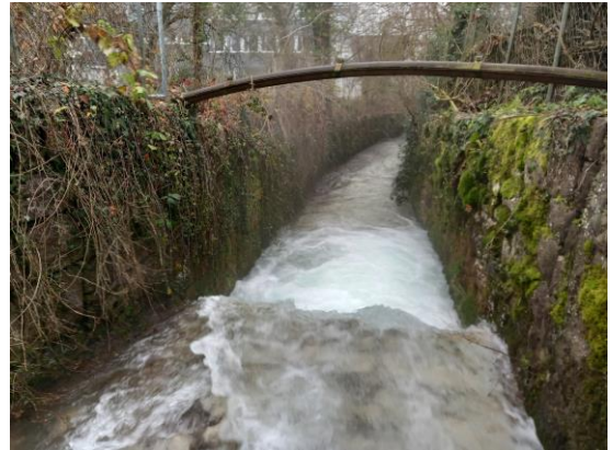
Abbildung 13: Überfall bei m 1456.37, h ca. 0.75 m und beim Überfall querende Swisscom / TV-Leitung (rechts)
