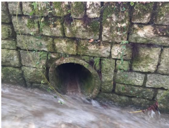
Abbildung 18: Auf Leitungskataster nicht vorhandene Einleitungen am linken Ufer SBR K 650 (ca. m 1427) und SBR K 300 (ca. m 1512)
