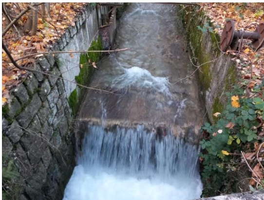
Abbildung 11: Überfall bei m 1415.37, h ca. 1.00 m, mit ehemaliger Installation einer Stauklappe für die Zuleitung zum Wasserkraftwerk Uhrenfabrik Langendorf
