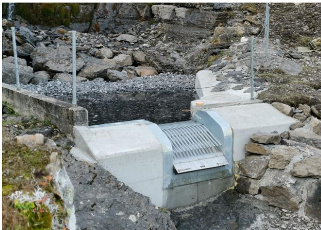
Abbildung 28: Beispiel Coanda-Rechen Optimus 300 mit Schutzgitter (Bilder: Firma Wild Metal GmbH)
