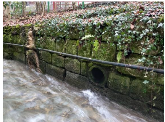
Abbildung 18: Auf Leitungskataster nicht vorhandene Einleitungen am linken Ufer SBR K 650 (ca. m 1427) und SBR K 300 (ca. m 1512)
