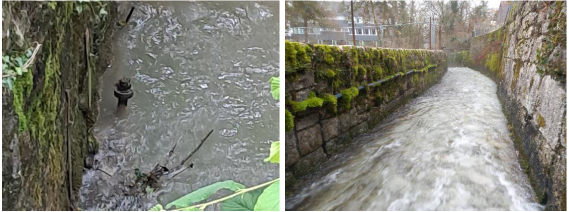
Abbildung 25: Ansaugstutzen (links) und entlang linker Mauer geführte Zuleitung (rechts) der bestehenden Weiherspeisung
