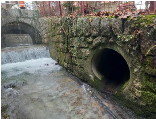
Abbildung 17: Linksufrige Einleitungen RW SBR K 1000 (ca. m 1549.00) und Entlastung RW SBR K 300 (ca. m 1507.00), im Leitungskataster ersichtlich.
