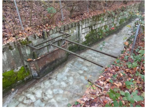
Abbildung 12: Einbauten der ehemaligen Wasserfassung für die Zuleitung zum WK Uhrenfabrik
