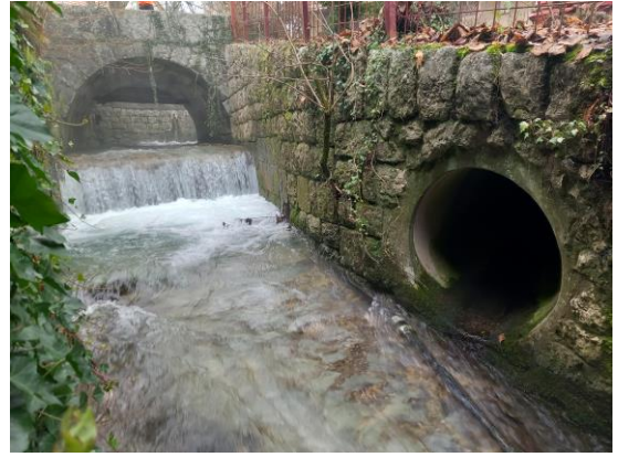
Abbildung 15: Überfall bei m 1555.77, h ca. 0.80 m, unterhalb Brücke Sagackerstrasse
