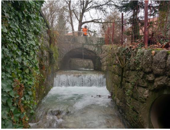
Abbildung 15: Überfall bei m 1555.77, h ca. 0.80 m, unterhalb Brücke Sagackerstrasse
