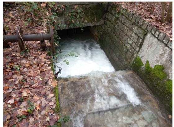
Abbildung 11: Überfall bei m 1415.37, h ca. 1.00 m, mit ehemaliger Installation einer Stauklappe für die Zuleitung zum Wasserkraftwerk Uhrenfabrik Langendorf
