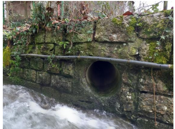
Abbildung 17: Linksufrige Einleitungen RW SBR K 1000 (ca. m 1549.00) und Entlastung RW SBR K 300 (ca. m 1507.00), im Leitungskataster ersichtlich.
