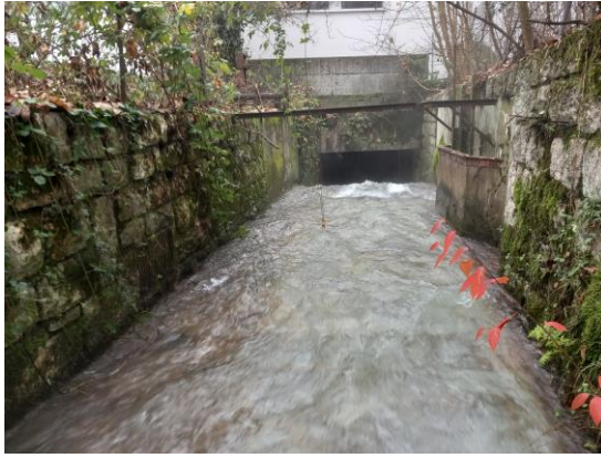
Abbildung 12: Einbauten der ehemaligen Wasserfassung für die Zuleitung zum WK Uhrenfabrik
