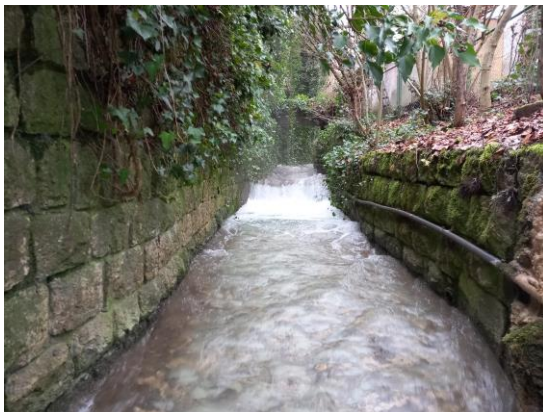
Abbildung 14: Überfall bei m 1529.24, h ca. 0.75 m. Der Überfall liegt im Bereich der Querung der Abwasserleitung
