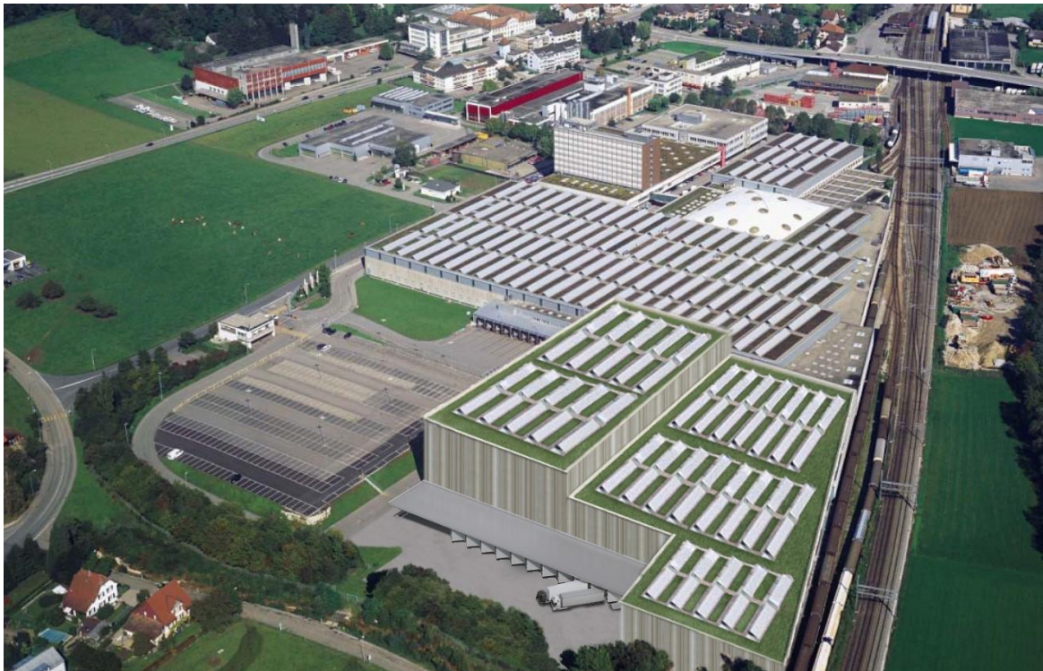
Abbildung 20 Coop NVZ mit Realisierung Sofortmassnahmen, Vogelperspektive von Südwesten. Grafik S+B
