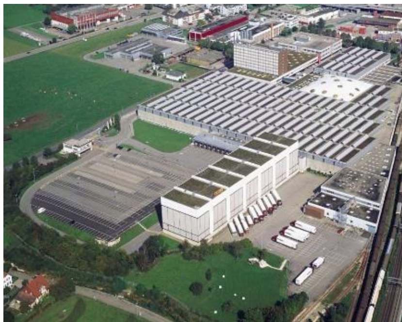
Abbildung 15 NVZ Coop Wangen b. Olten / Rickenbach heute: Luftbild (Blick von Südwesten)
