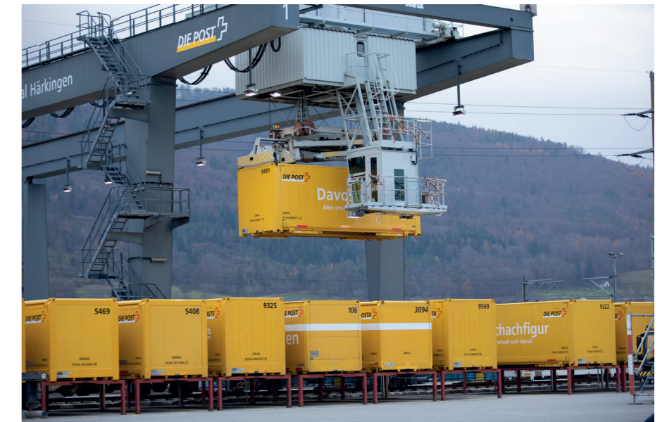
Bestehende Portalkrananlage PZ Härkingen
