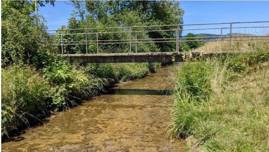
Abbildung 8: Brücke Mündung Eibach (Blick Richtung Stromaufwärts)
