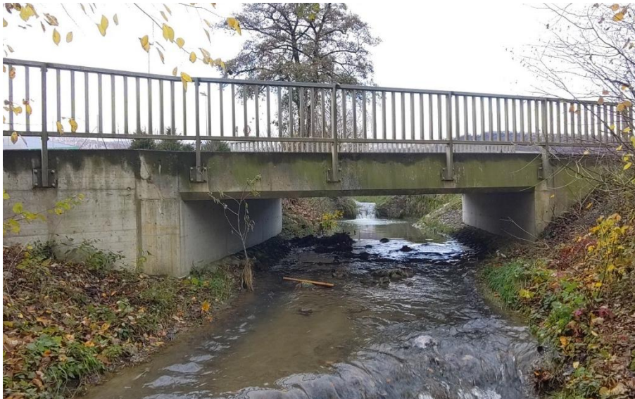
Abbildung 10: Brücke Grubenstrasse (Blick Richtung Stromaufwärts)
