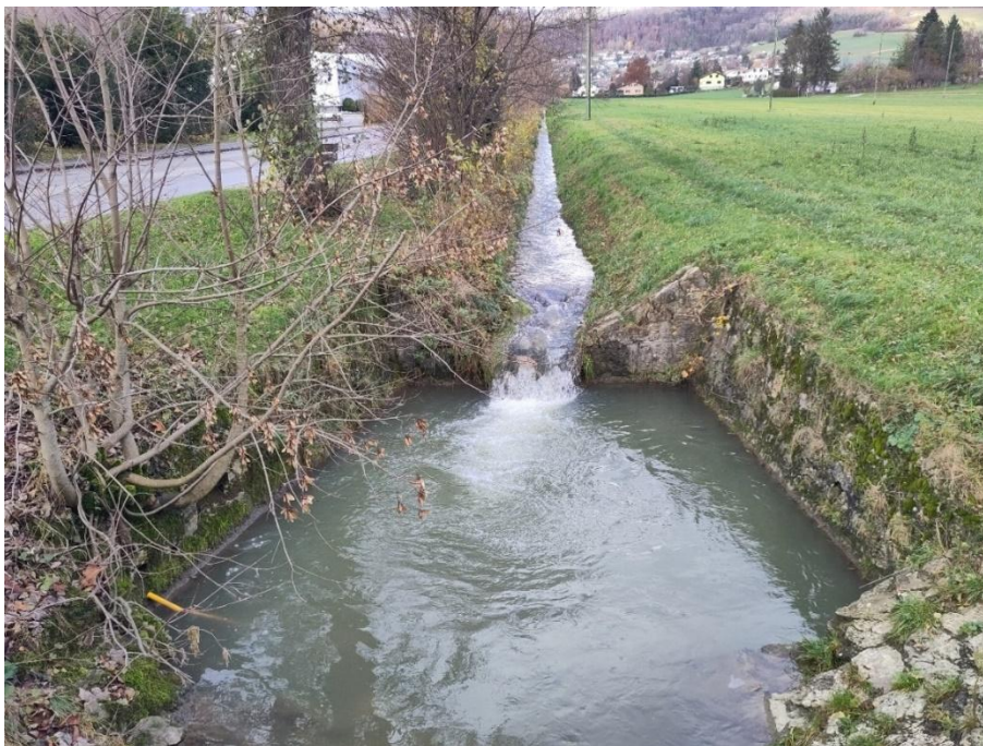
Abbildung 21: bestehender Absturz mit Tosbecken beim Losterferbach
