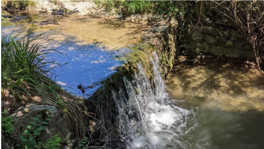
Abbildung 20: Absturz Stegbach m 0+735)
