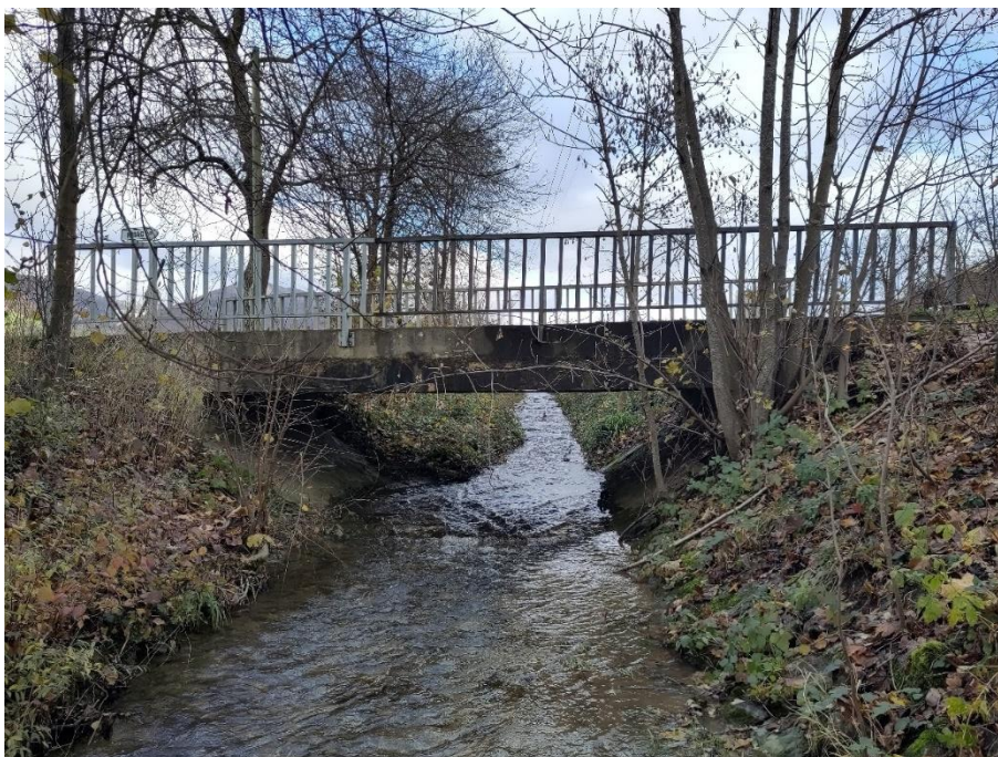
Abbildung 9: Brücke Buerstrasse (Blick Richtung Stromaufwärts)
