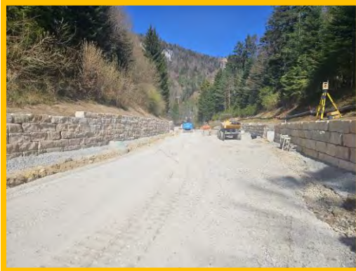
Fahrbahnerneuerung vor Oberdorf
