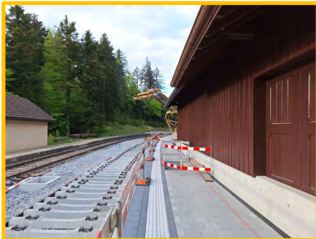
Erneuerung Gleis- und Perronanlage
