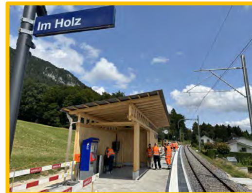
Finisharbeiten Haltestelle Im Holz
