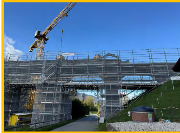
Gerüst und Kran
