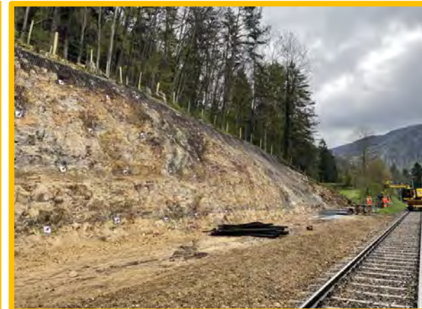
Vorbereitungsarbeiten Felswand bei der Haltestelle Crémînes Zoo
