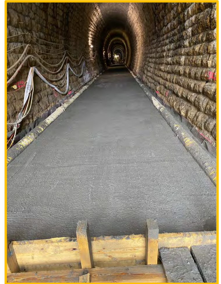
Frisch eingebrachte Betonsohle
