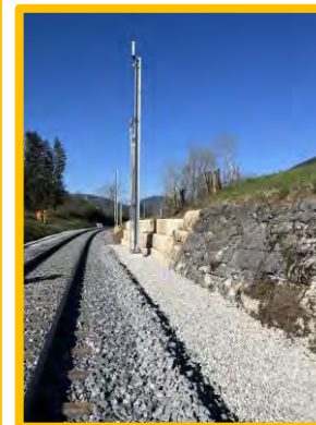
Vorbereitungsarbeiten Blocksteinmauer bei der Haltestelle Grandval
