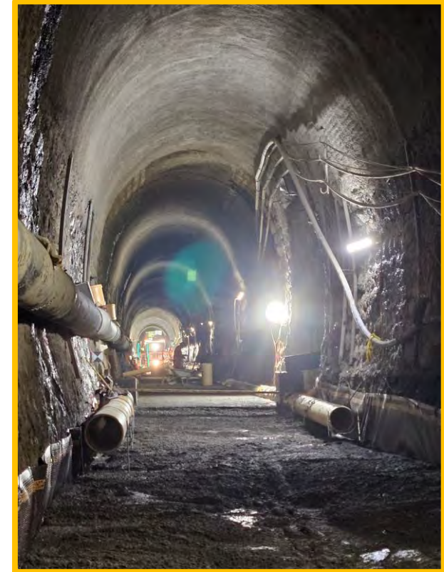
Seitliche Entwässerungsleitungen
