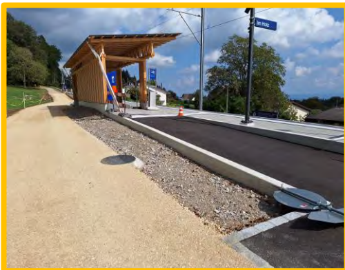
Finisharbeiten Haltestelle Im Holz
