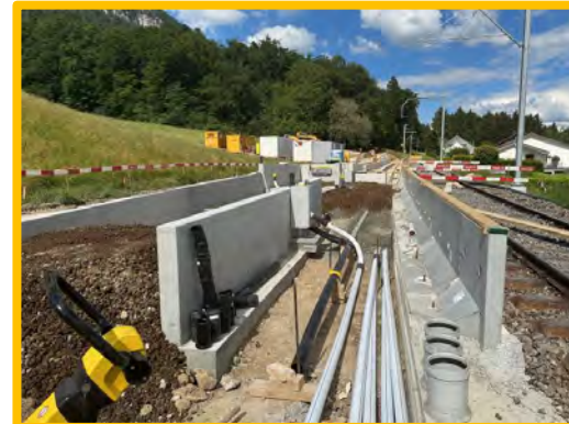
Tiefbauarbeiten Haltestelle im Holz
